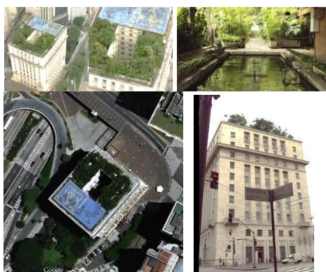
Edifício sede da Prefeitura de São Paulo (SP)
