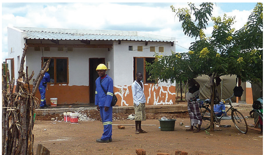
Obras de reparos nas casas rachadas no reassentamento de Cateme/Moçambique.
