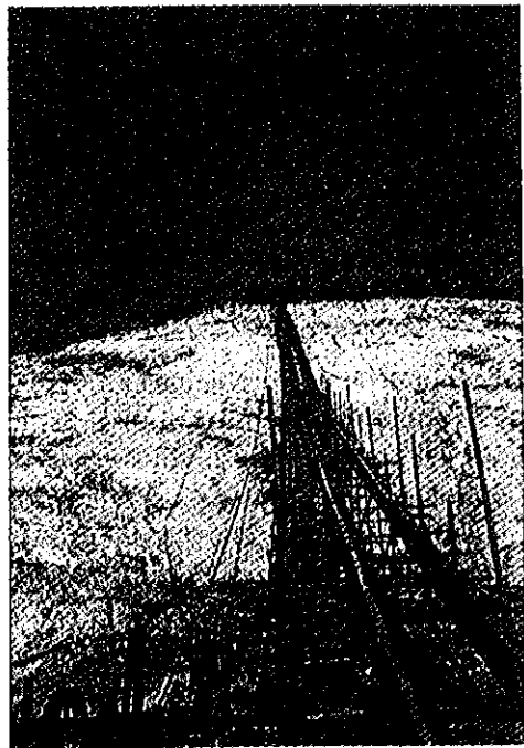
Fig. 4G — Obra de contenção de encosta na Rodovia Rio—Santos. Mesmo com a contenção pode-se notar a presença de material que está deslizando. Foto A. J. T. Guerra
