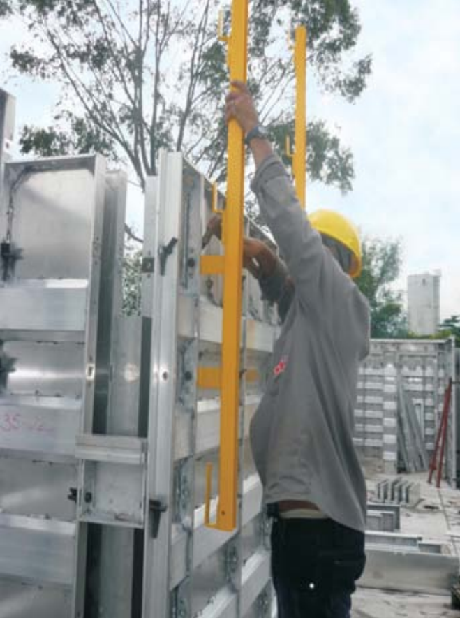
As fôrmas para laje são preparadas para encaixe das escoras
