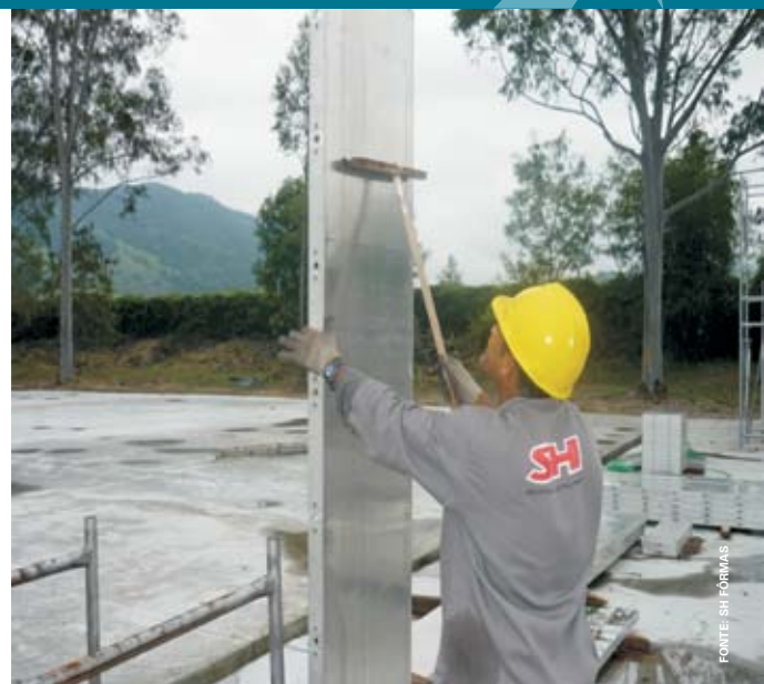
A aplicação do desmoldante deve ocorrer antes de cada concretagem
