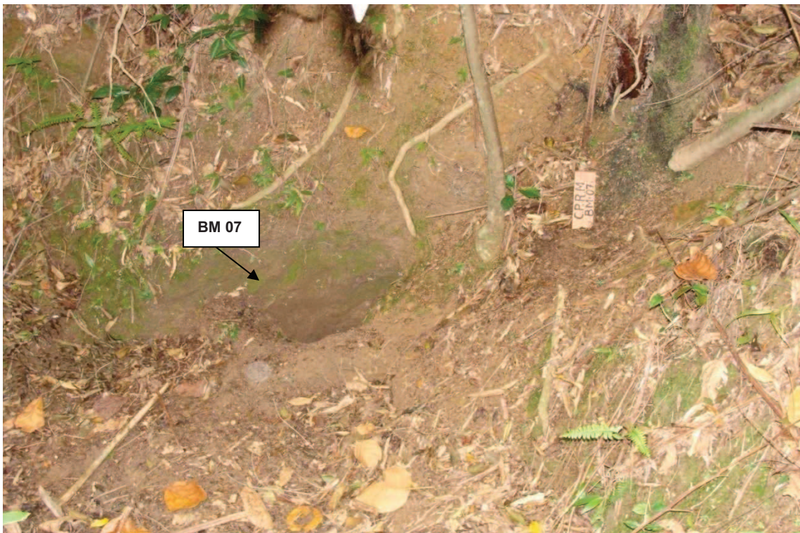
Figura 35: BM 07 quase totalmente obstruída, atuando como área de recarga para o interior da mina. (CANCELIER, 2009)
