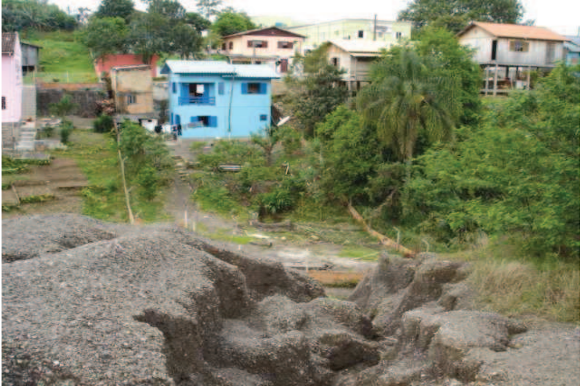
Figura 11: Proximidade da pilha de rejeito com a área urbana, na porção sul da área de estudo. (Fonte: CANCELIER, 2009)
