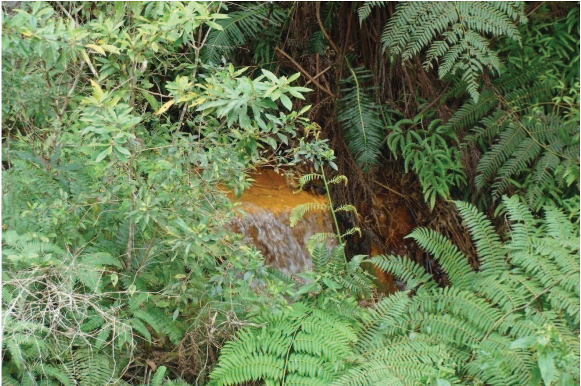
Figura 21: Drenagem à jusante da BM 01 que passa abaixo do depósito de rejeito. (Fonte: CANCELIER, 2009)
