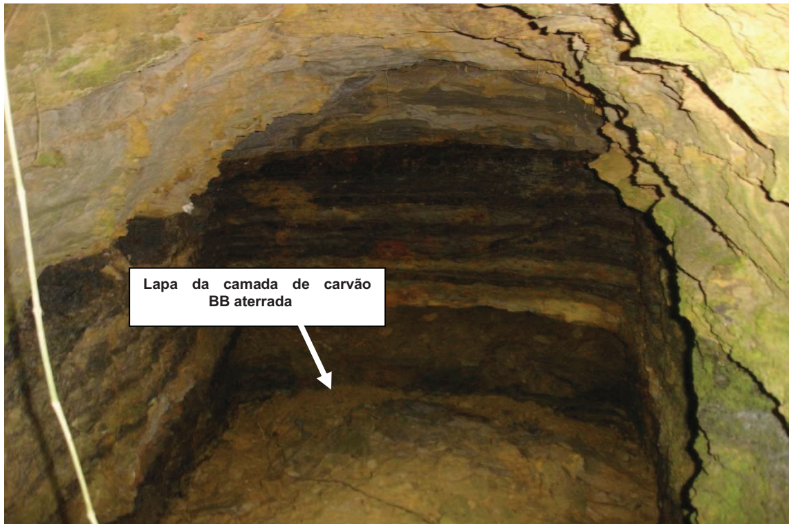
Figura 32: BM 04 aberta sendo assoreada por caimentos e solapamentos. Detalhe do forro, quadração e banco da camada de carvão Barro Branco. (Fonte: CANCELIER, 2009)
