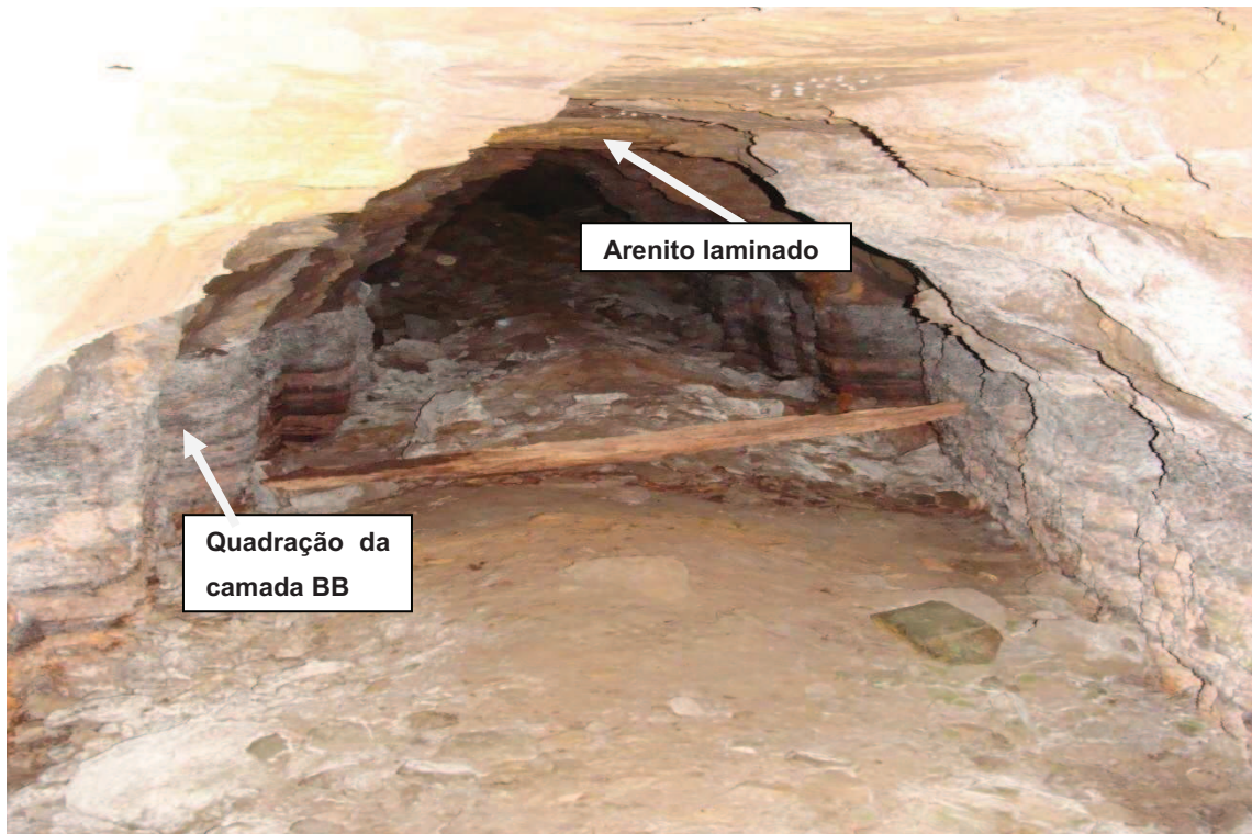
Figura 37: Vista interna da galeria, evidenciando a quadração da camada de carvão Barro Branco e o teto imediato constituído por arenito alterado. (CANCELIER, 2009)
