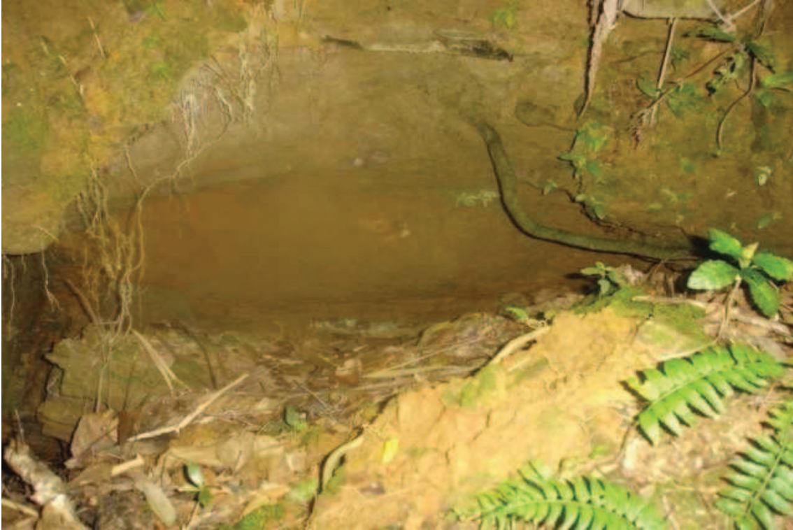
Figura 31: Detalhe da boca da mina 03 demonstrando a sua obstrução através de desmoronamentos. (Fonte: CANCELIER, 2009)
