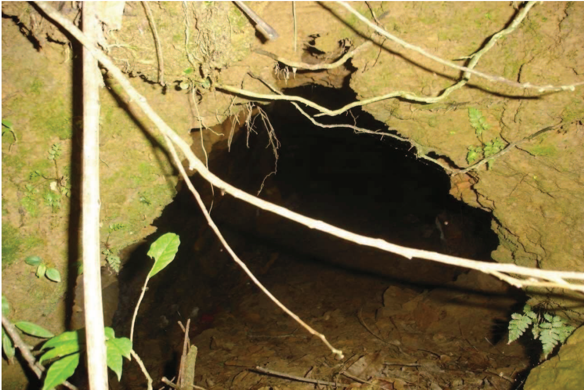
Figura 39: BM 100 com evidências de assoreamento da galeria e caimentos. (Fonte: CANCELIER, 2009)
