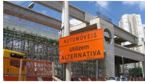
Figura 23 - Sinalização de obras de metropolitanos em viários
