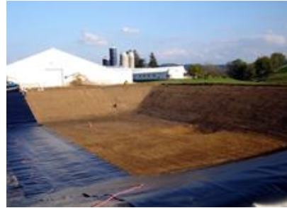
Figura 40 - Sistema de impermeabilização de base
