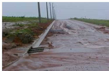
Figura 43 - Carreamento de solo em obras de loteamentos
