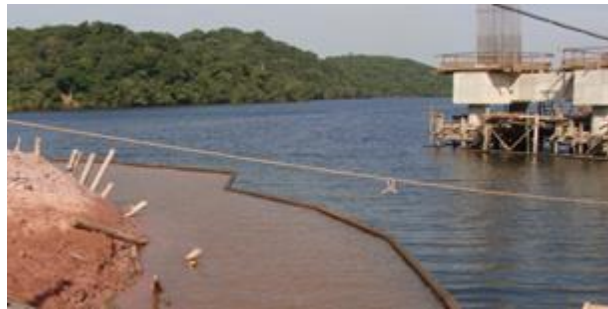
Figura 24 - Uso de barreira para contenção de sedimentos em obras rodoviárias
