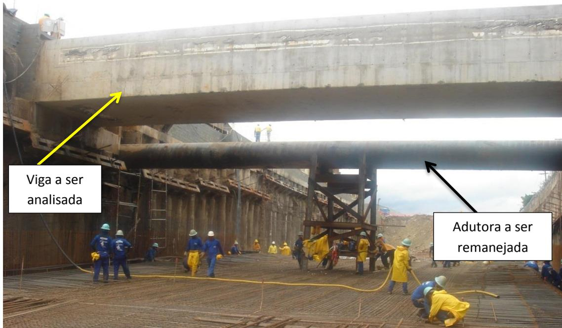
**Figura** – Vista geral da viga de concreto para suporte de adutora a ser remanejada.
