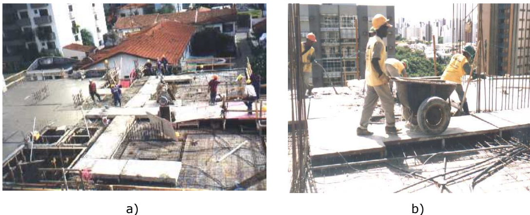
Figura 4.3 – a) e b) Passarelas para movimentação de jericas em concretagem de laje.
