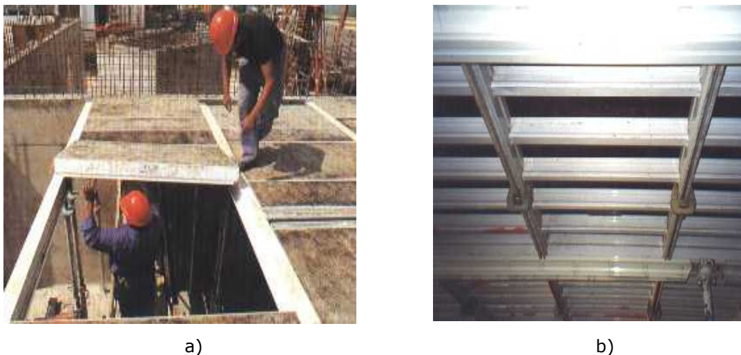
Figura 2.37 – Sistema modular para lajes: a) montagem dos painéis apoiando-os em vigas metálicas; b) vista inferior do sistema montado.
