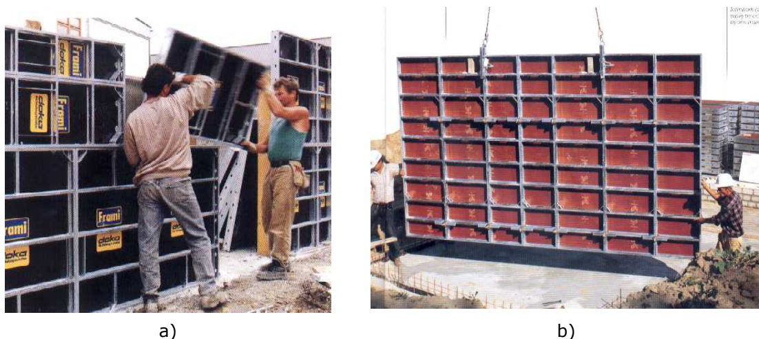
Figura 2.30 - Sistema modular: a) montagem de fôrma de parede com painéis metálicos (Doka, s.d.); b) movimentação de painel de fôrma composto por painéis metálicos modulares associados (SH, s.d.).
