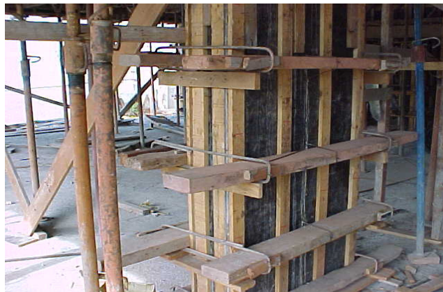
Figura 2.27 – Vigas de travamento de madeira maciça associadas a grampos de aço.
