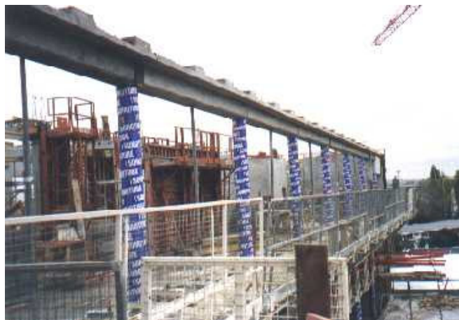
Figura 2.23 – Fôrmas de papelão para pilares de seção circular.
