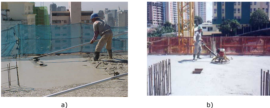
Figura 4.10 – Desempenadeiras: a) Bull float ; b) Helicóptero .
