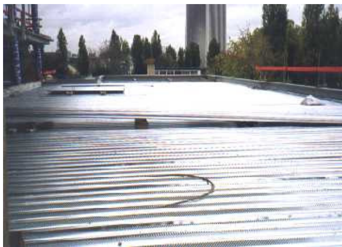
Figura 2.19 – Fôrma com molde de aço que ficará incorporado ao concreto (tipo steel deck ).
