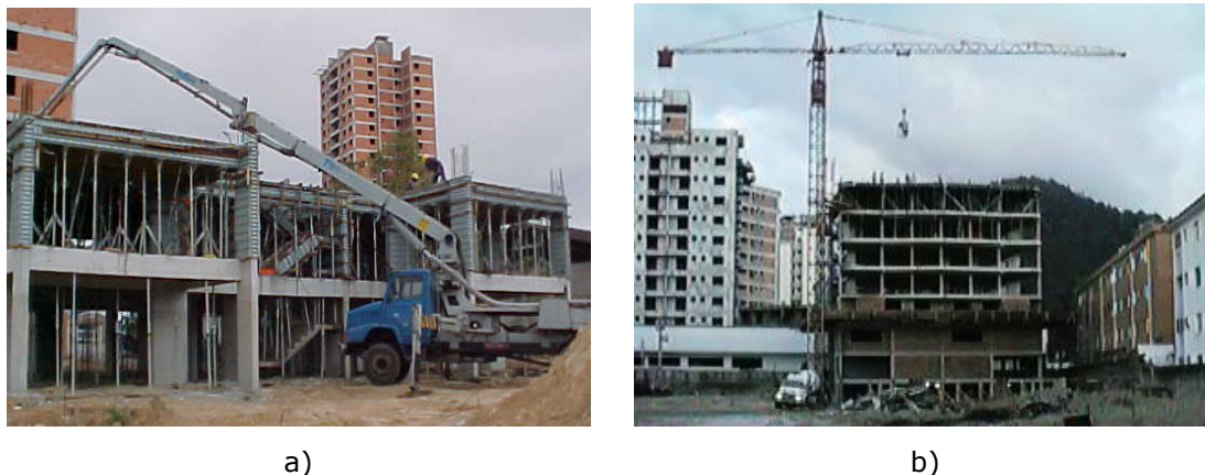
Figura 4.4 – Equipamentos para transporte de concreto sem decomposição do movimento: a) bomba-lança; b) grua.
