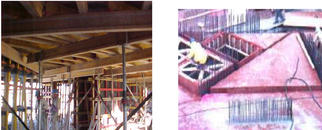
Figura 2.40 – Exemplo de flexibilidade do sistema tramado com a moldagem de laje em formato triangular: a) vista inferior do cimbramento da laje; b) vista superior do molde da laje.
