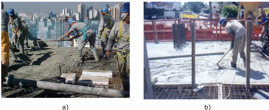
Figura 4.6 – a) e b) Espalhamento do concreto.
