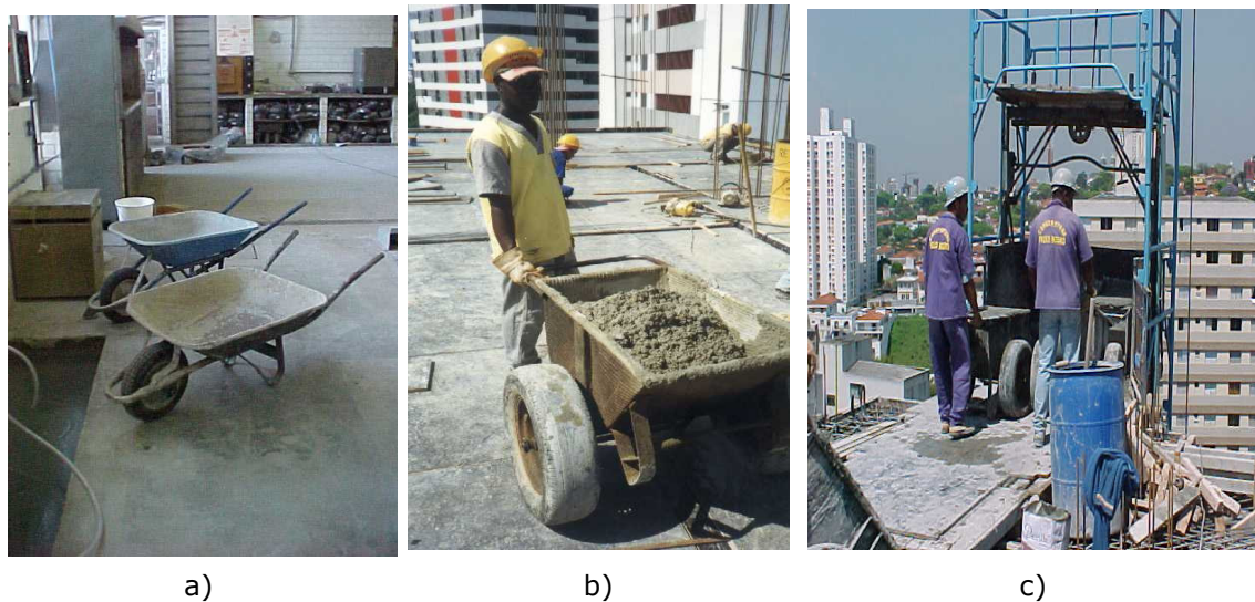
Figura 4.2 – Equipamentos para transporte de concreto com decomposição do movimento: a) carrinhos-de-mão; b) jérica; c) elevador de carga.
