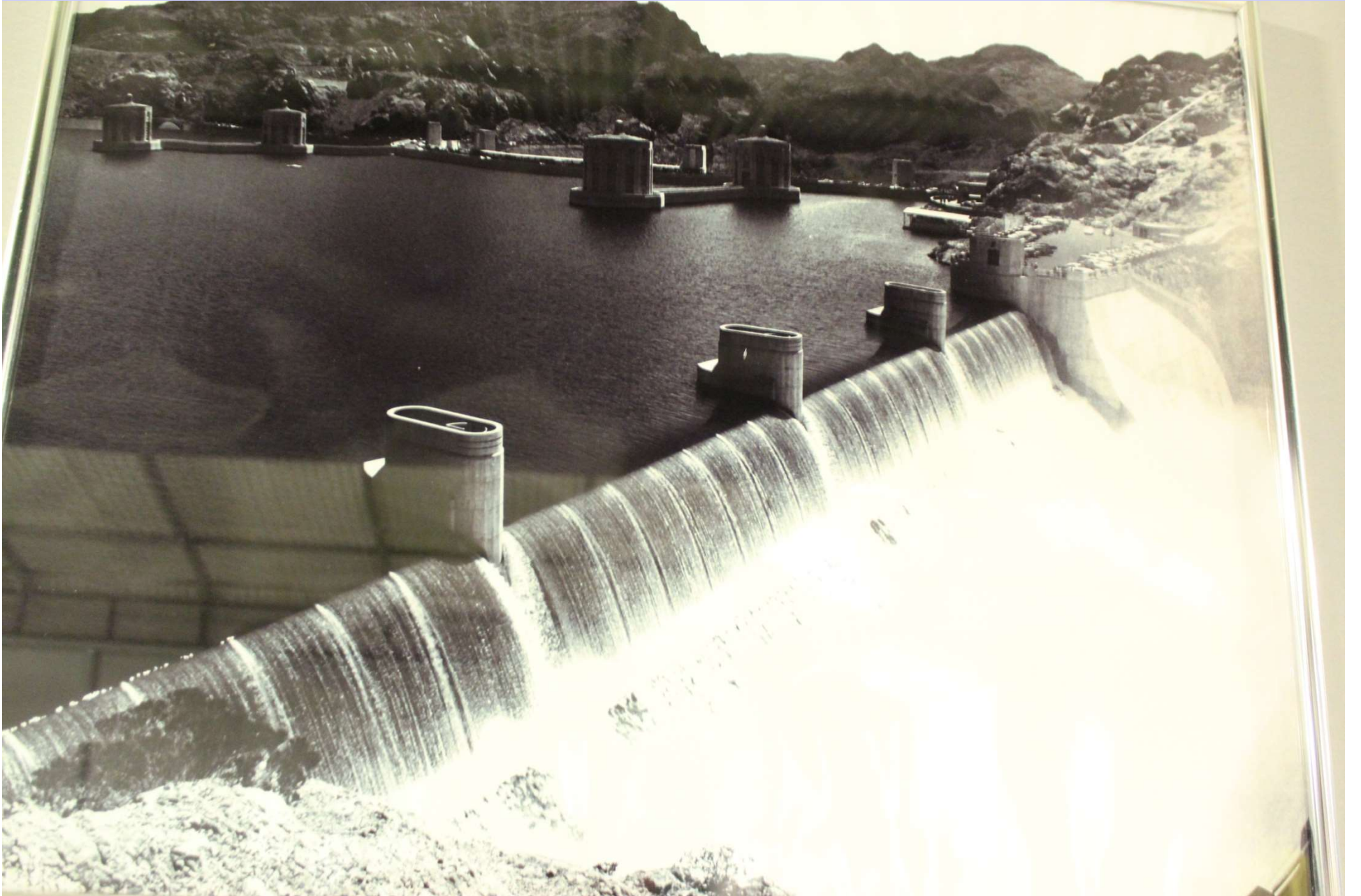
Overtopping em junho de 1983
