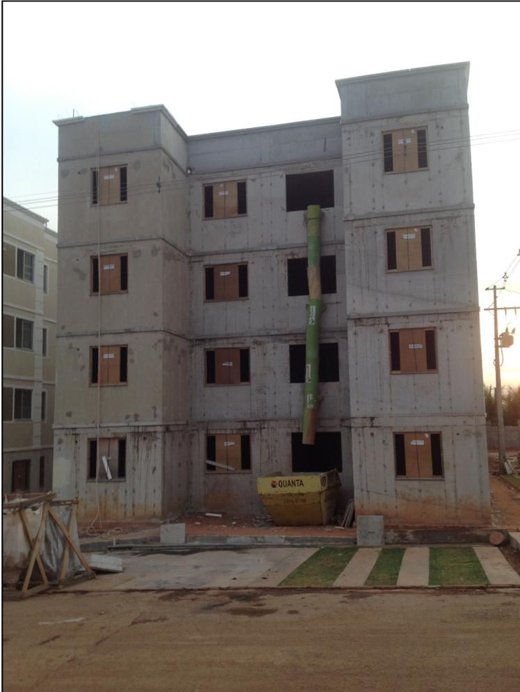
Foto 6: bloco com as esquadrias instaladas
