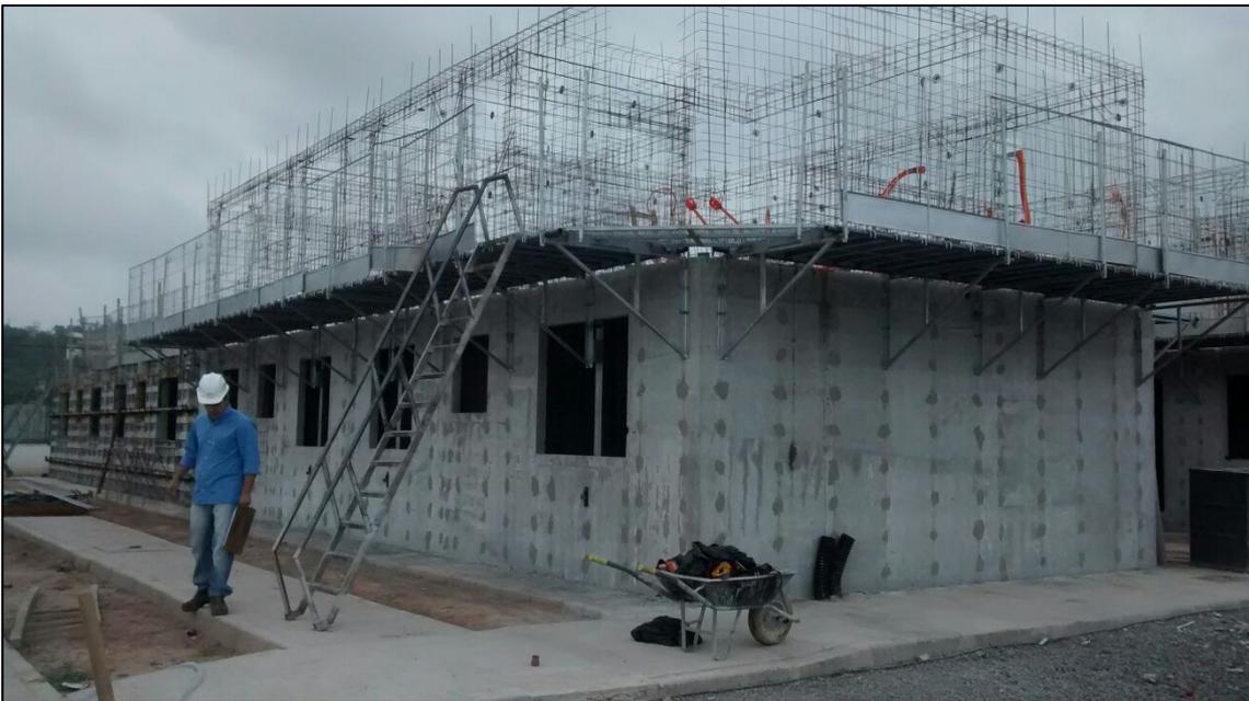
Foto 5: formas com o detalhe da ferragem e tubulação do segundo pavimento
