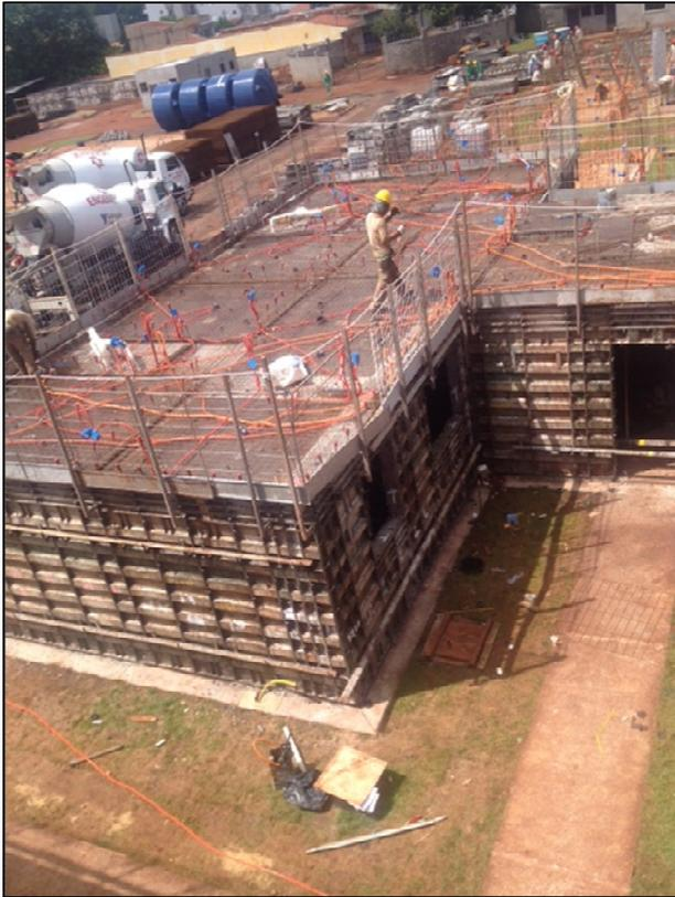
Foto 3: formas com o detalhe de tubulações
