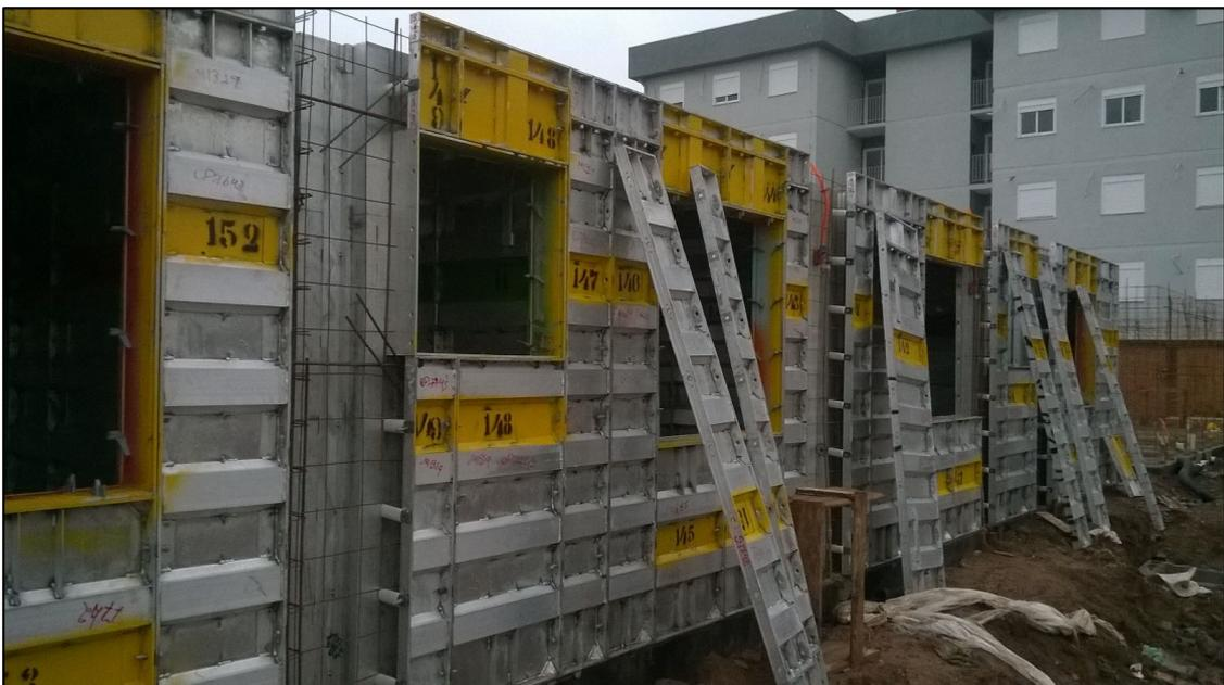
Foto 2: formas com o detalhe da ferragem e identificação das peças
