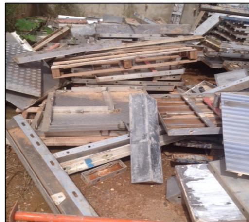
Fotos 7 e 8: transporte e mau exemplo de acondicionamento das formas
