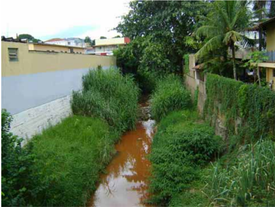
Foto 06: Urbanização a margem do córrego Samambaia.
