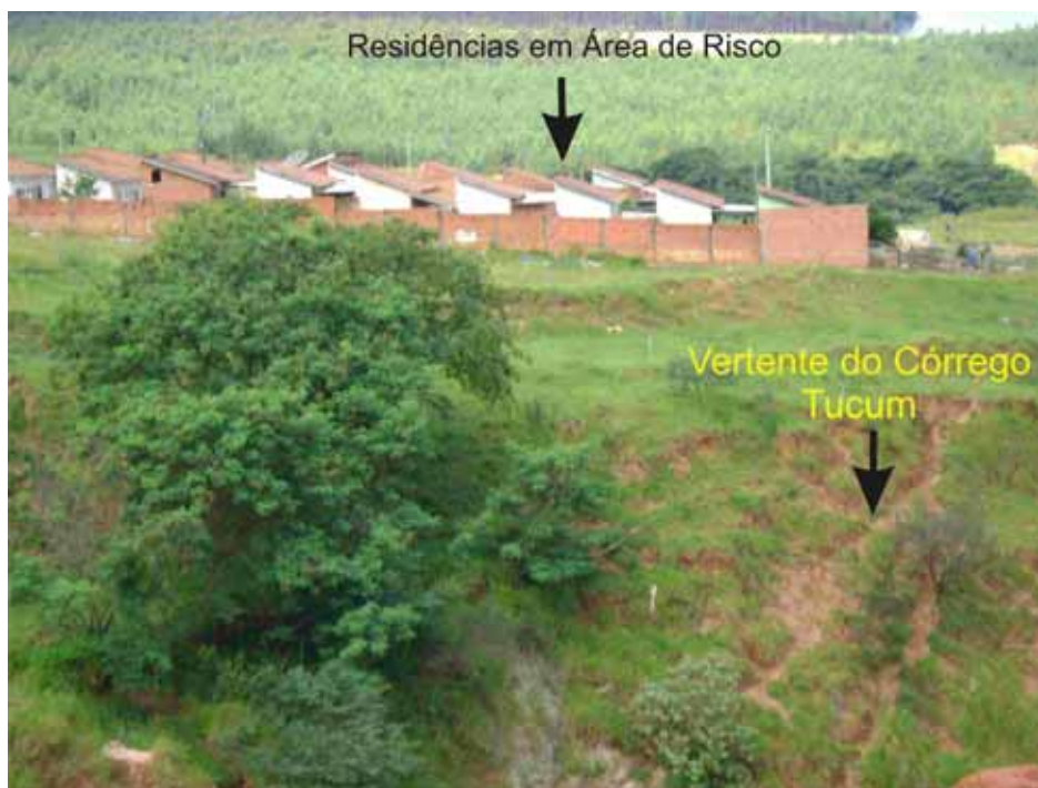
Foto 10: Residências em situação de risco próxima a vertente da voçoroca do córrego Tucum.
