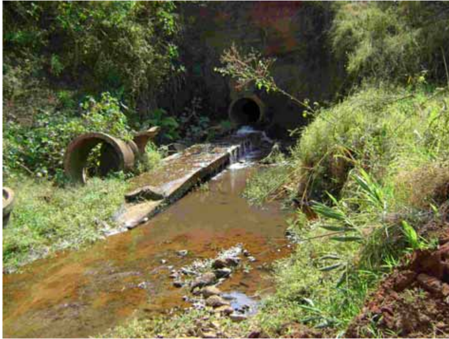
Foto 08: Obras de Construção Civil no córrego Samambaia.
