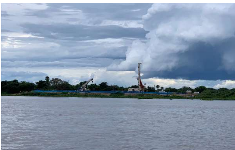
Figura 5. Obras en el puente binacional, vistas desde el lado brasileiro
