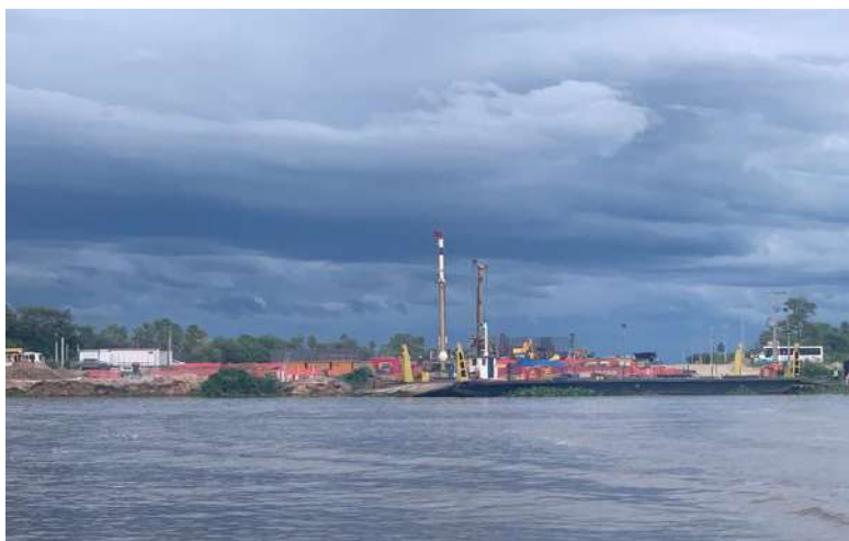
Figura 4. Obras en el puente binacional, vistas desde el lado paraguayo
