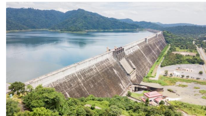
Barragem de contenção de água.
