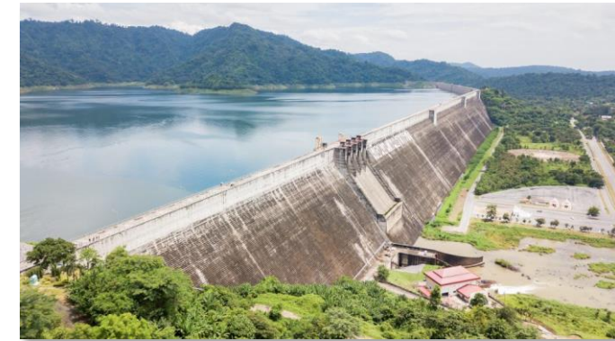
Barragem de contenção de água.
