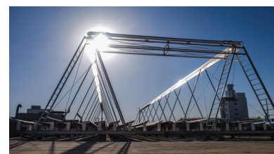
Foto: Industrial Solar / Silke Anders
