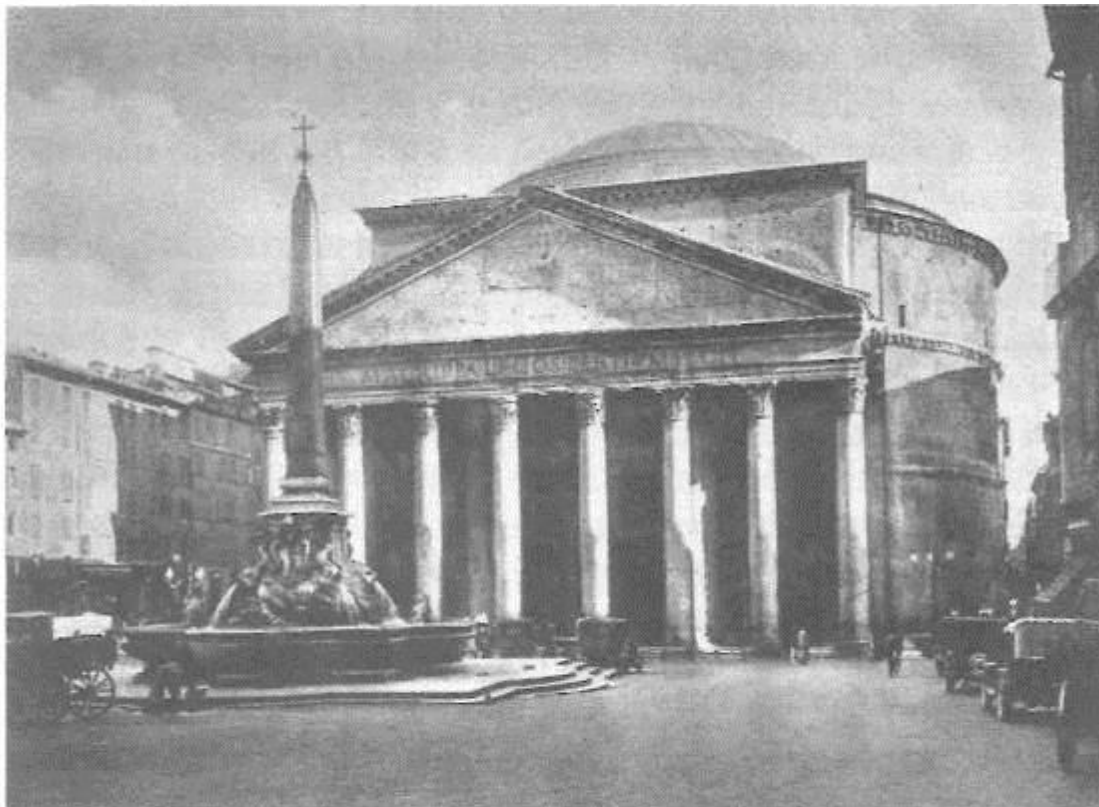
O Pantheon foi um templo circular monumental construído à época de Adriano, no segundo século d.C. e o diâmetro do seu domo, de 43,5 metros é maior do que a Basílica de São Pedro, em Roma (Terrasse, op. cit., p. 149).
