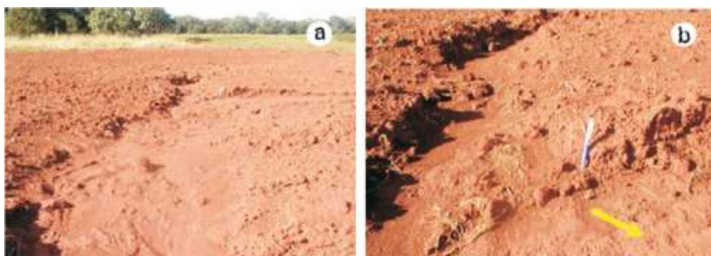
Suco de erosão em área compactada (a) e detalhe do sulco de erosão, mostrando a ocorrência do pé-de-grade (seta) (b).
