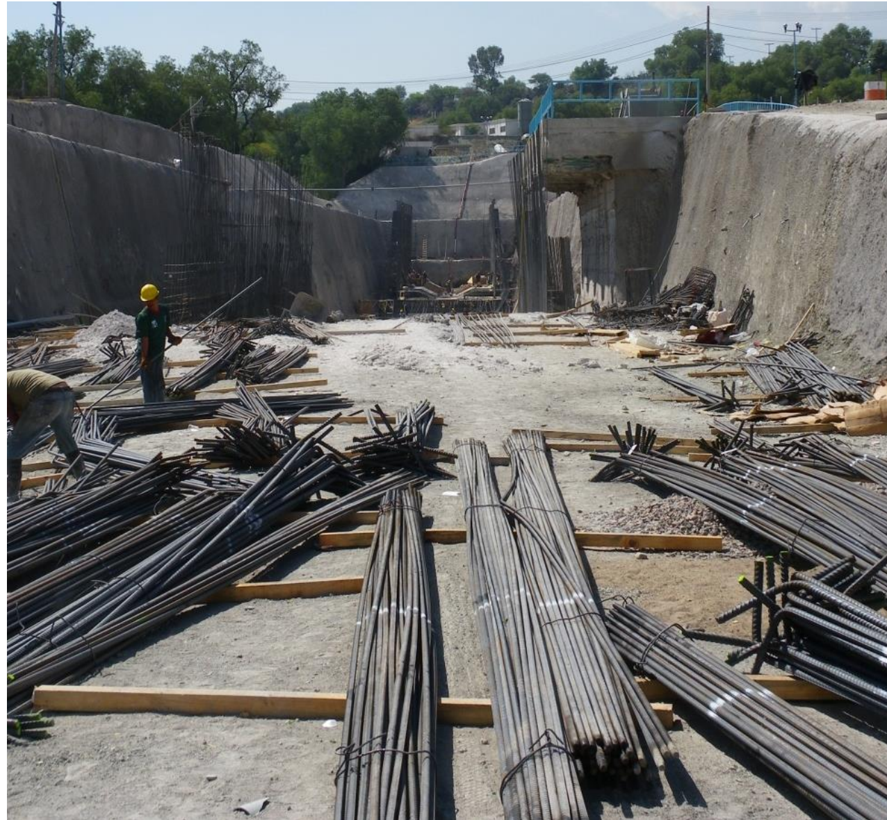
Construção de emissor
