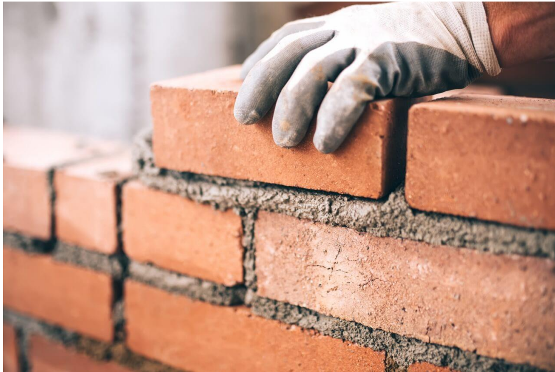
Argamassa de assentamento
