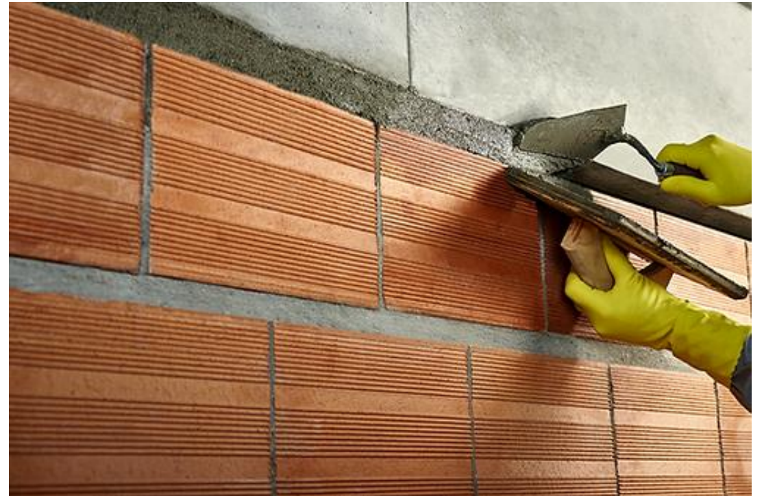
Argamassa de fixação e encunhamento
