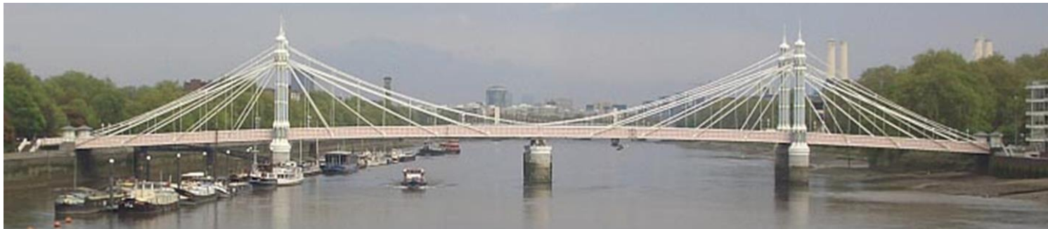
Albert Bridge (1873, vão livre 122m)
