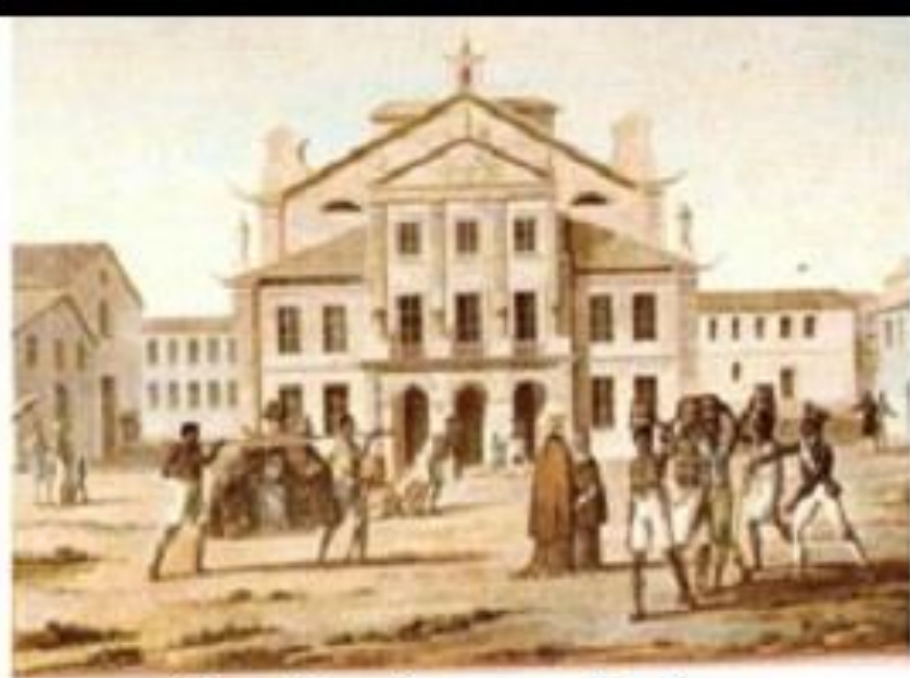
Fachada do Real Teatro São João
