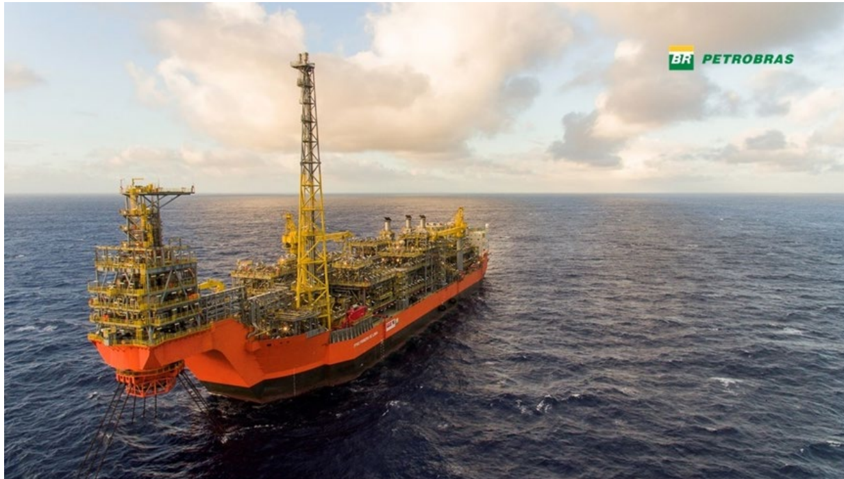
FPSO Pioneiro de Libra – Campo de Mero
