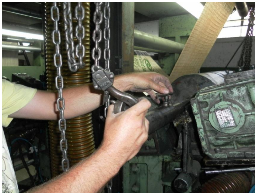
Figura 3.32 – Parafusando a talha. Fonte: Próprio autor.
