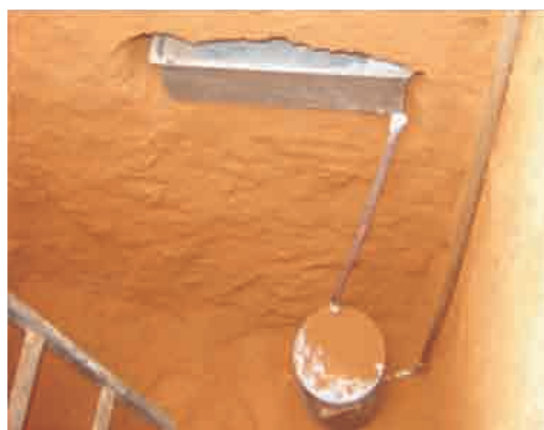
Figura 4.1.22 - Lisímetro ou infiltrômetro: (a) figura esquemática do dispositivo, (b) e (c) fotos mostrando o processo de instalação (fotos cedidas pela CPRM).
