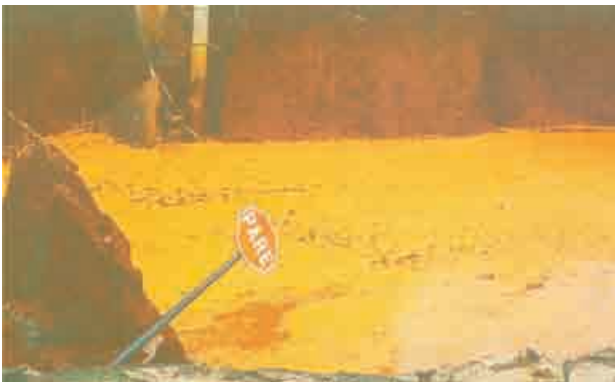
Figura 3.3.25 - Detalhe do colapso do terreno na cidade de Sete Lagoas - MG.
