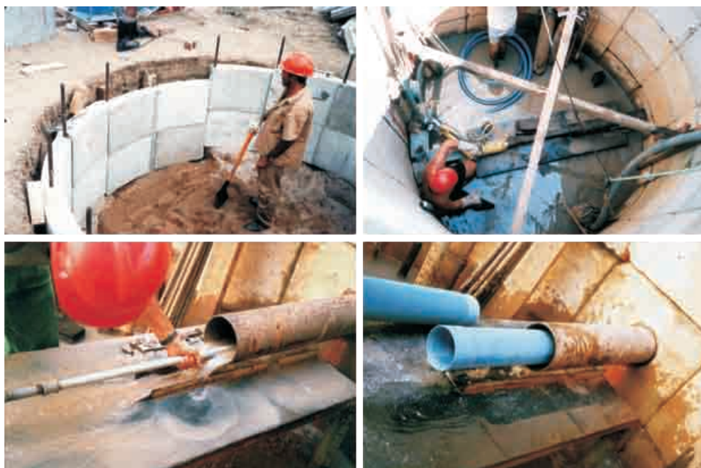
Figura 6.1.2 - Processo construtivo de poços amazonas com drenos radiais desenvolvido pela CPRM (Fotos: Ubaldo de Sá).
