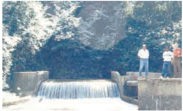
Figura 3.3.14 - Surgência do rio do Cedro, Montes Claros / MG.
