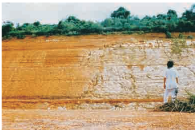
Figura 3.3.23 - Colapso do terreno preenchido por argila alógena, carste de Confins / MG.
