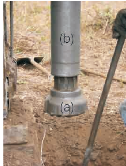
Figura 6.1.15 - (a) Bit (broca) e (b) martelo utilizados na perfuração rotopneumática.
