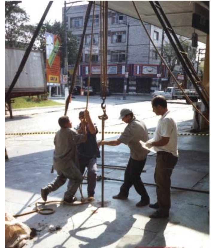
Perfuração com trado manual e tripé de sondagem tipo SPT.
