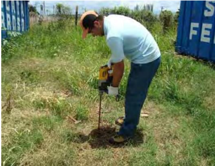
Perfuração com martetele roto-percussivo.
