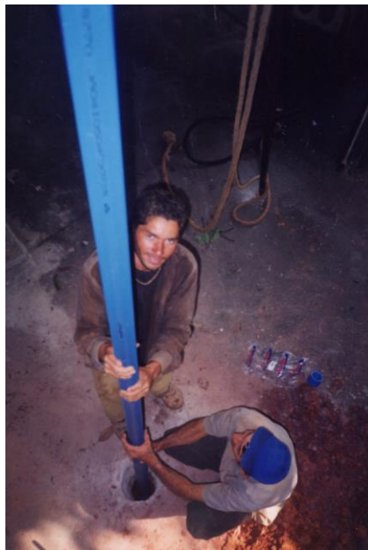
Alinhamento do tubo no furo de sondagem
