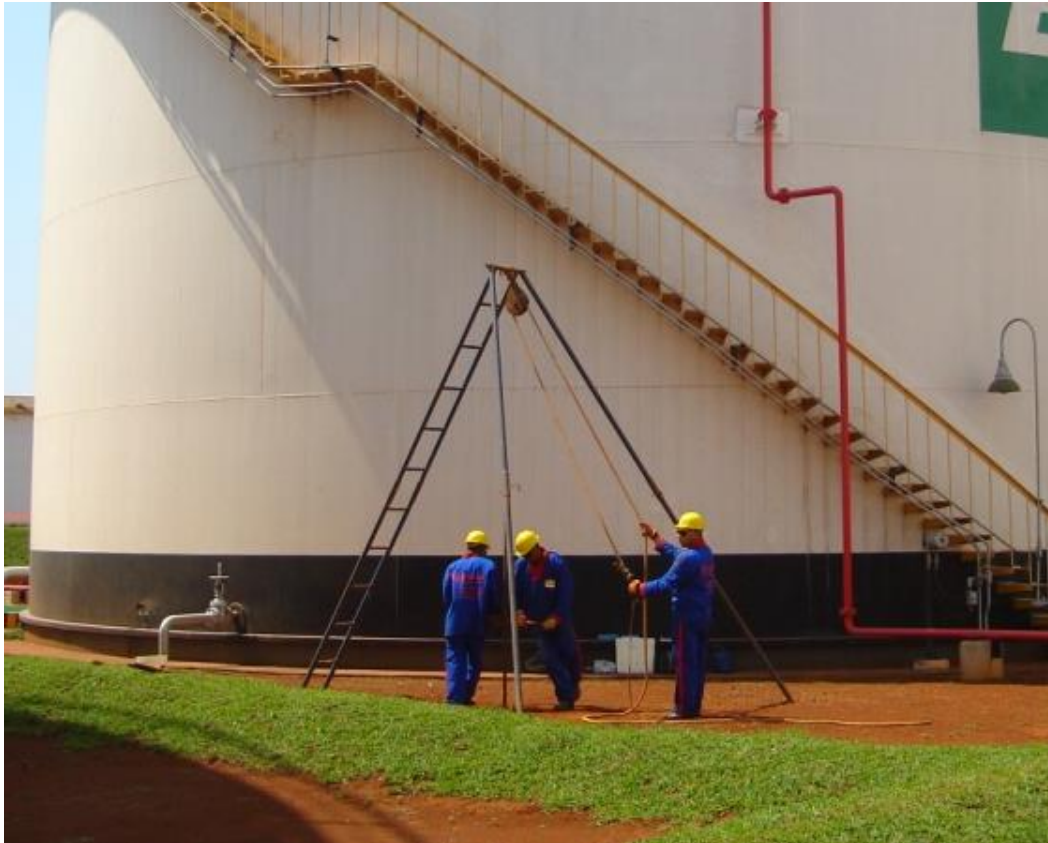
Perfuração com trado manual e tripé de sondagem tipo SPT.
