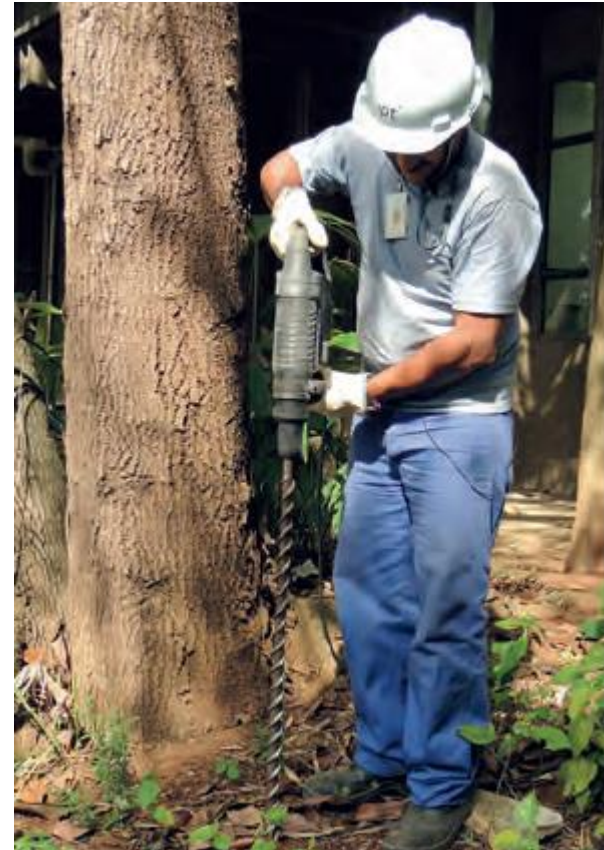
Perfuração com perfuratriz roto-percussiva (GeoHamer adaptado)
