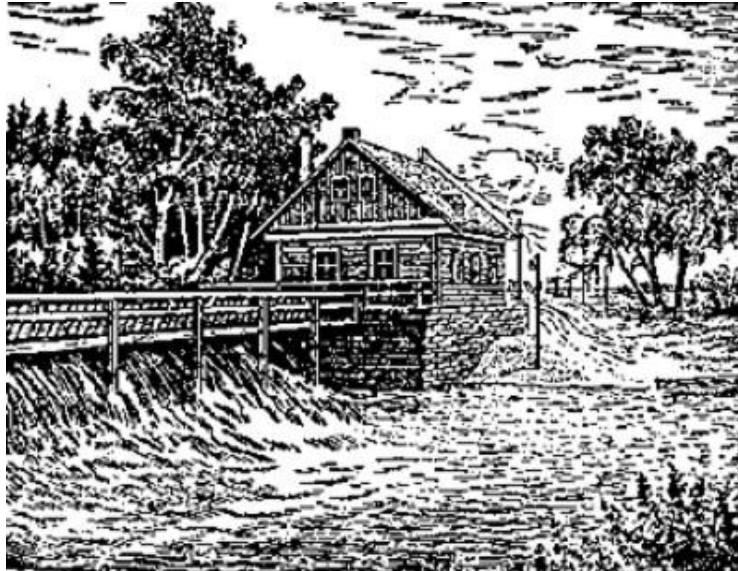
Figura 43. Central hidroeléctrica de un artel agrícola de Burmakin; genera 80 kilovatios de potencia y suministra energía a siete koljoces.
