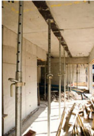
O plano operacional para o escoramento remanescente deve contar com projeto próprio, implicando diretamente nas propriedades do concreto. Os principais itens são o ciclo de concretagem, as características do concreto ao executar a laje imediatamente acima, a sobrecarga de utilização das lajes, o peso próprio, as características e o posicionamento das escoras e a quantidade de jogos necessários.
