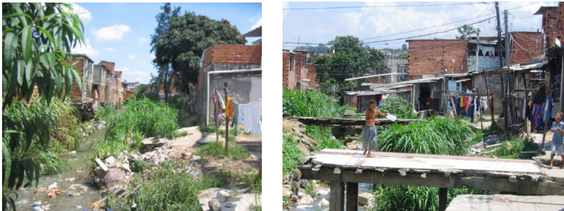
Figura 2–Imagens do Córrego ocupado antes da intervenção. Fonte: GROSBAUM, 2012, p. 149.
