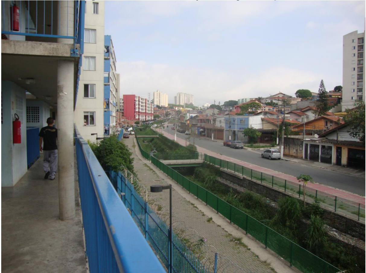
Figura 44 - Vista Canalização córrego do Sapé
