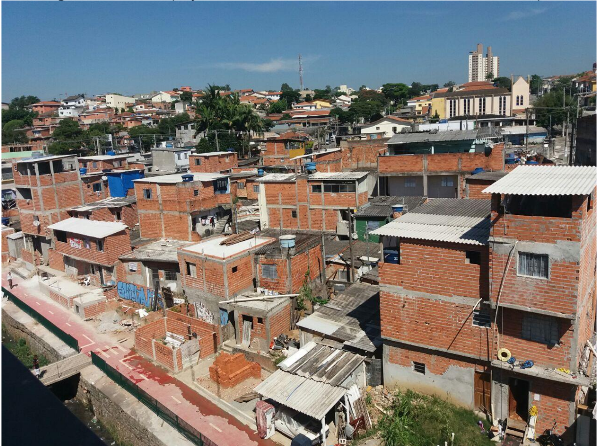
Figura 47 - Reocupações e área extremamente densa da favela do Sapé
