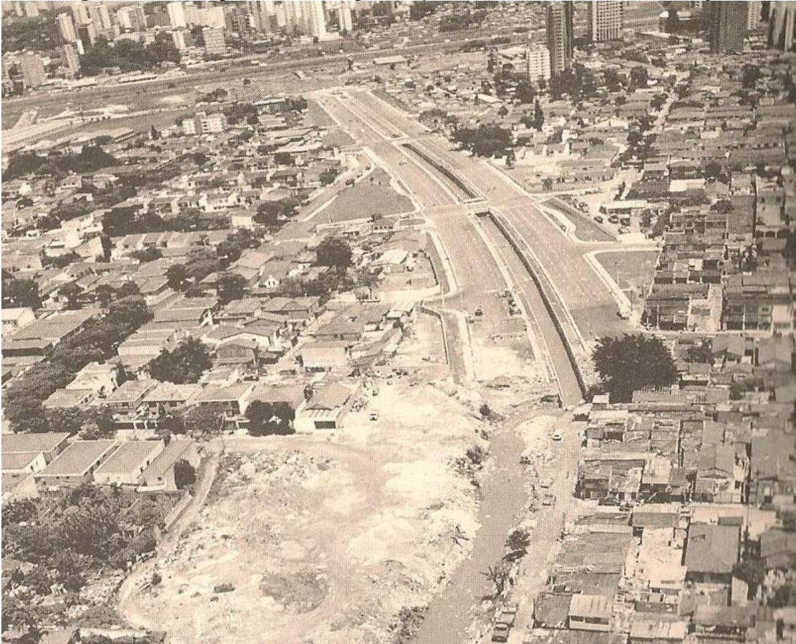
Figura 23 - Imagem da Av. Água Espreiada durante sua construção
