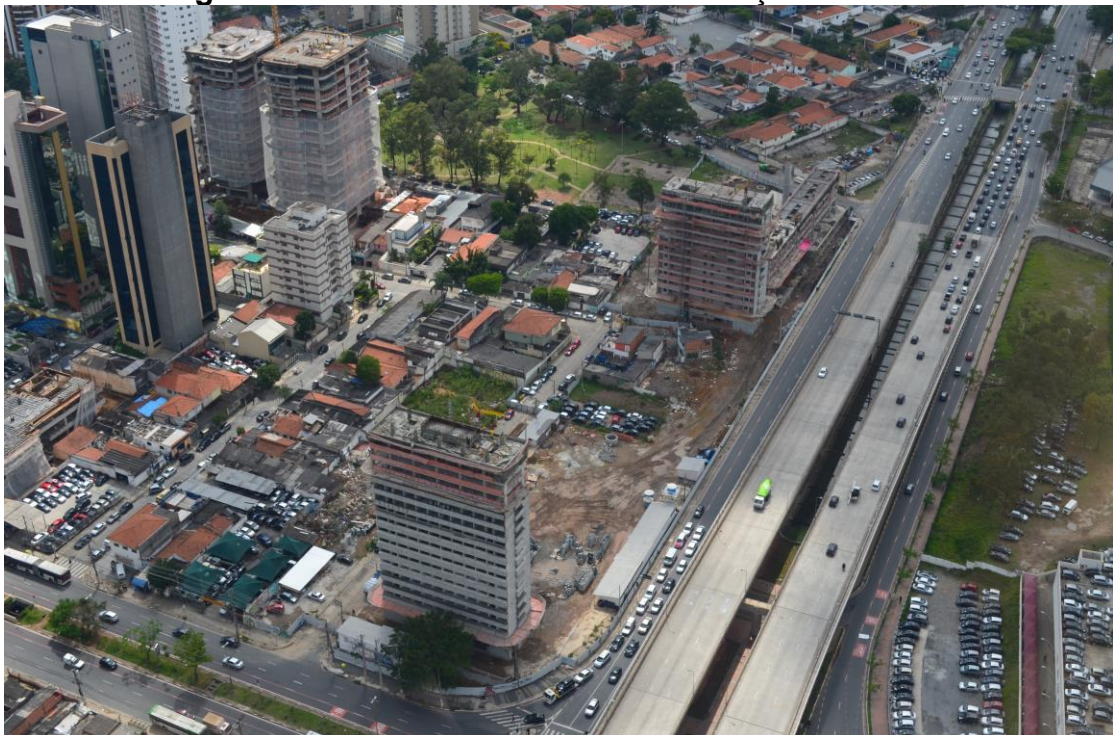
Figura 32 - Jardim Edite durante a execução das obras
