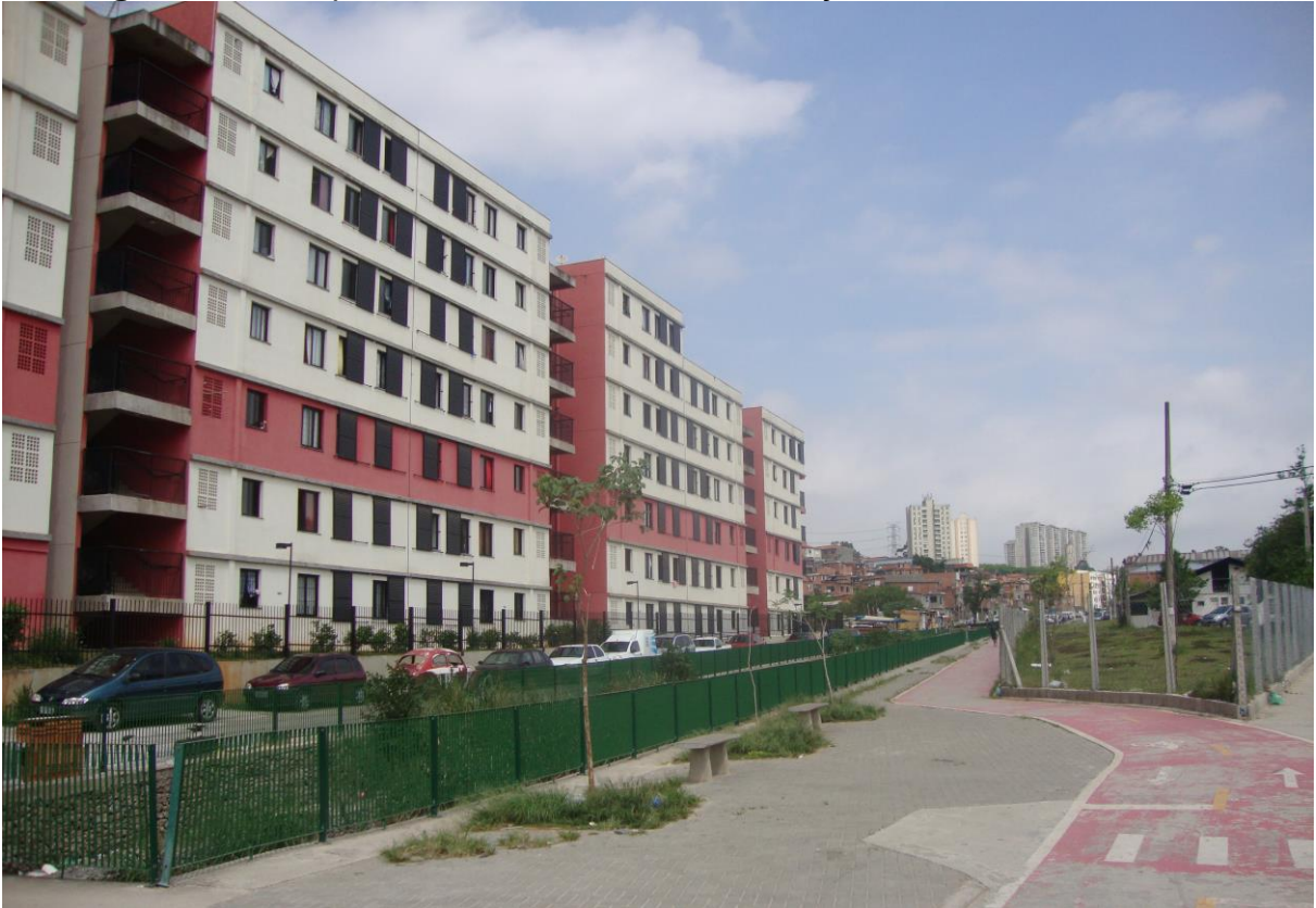
Figura 42 - Parque linear e ausência de iluminação nas áreas urbanizadas
