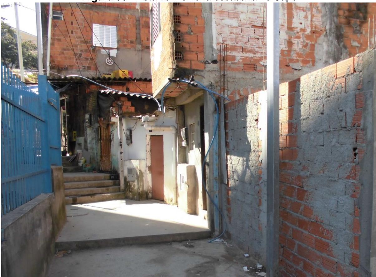
Figura 56 - Detalhe melhoria escadaria no Sapé
