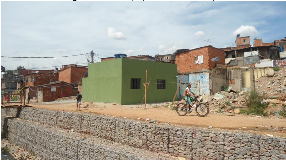
Figura 55 - Readequação executada no Sapé
