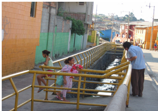
CÓRREGO CANALIZADO A CÉU ABERTO
