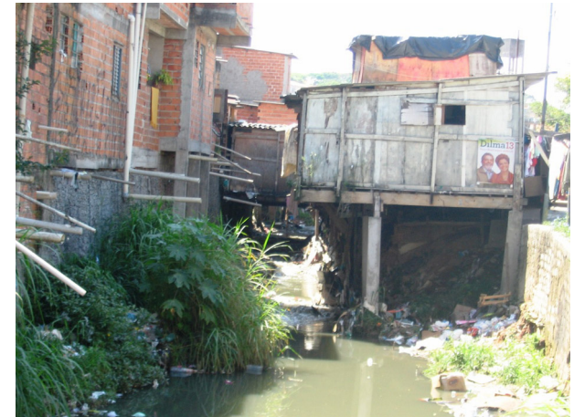
LANÇAMENTO DE ESGOTO NO CÓRREGO
