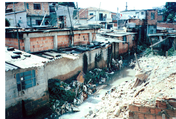
CASAS SOBRE O CÓRREGO ANTES DAS OBRAS
