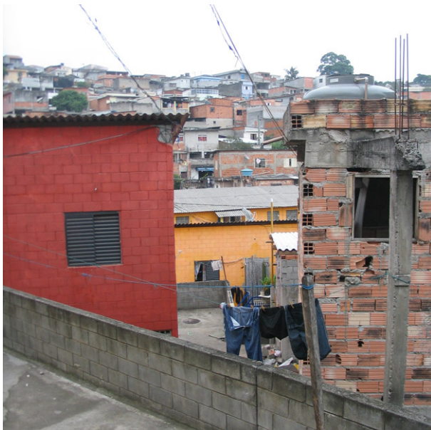
NOVAS U.HS. IMPLANTADAS NA ENCOSTA
