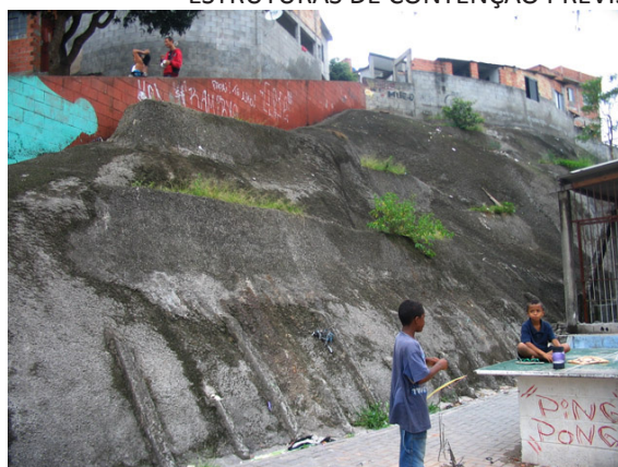
CONTENÇÃO DA ENCOSTA COM CONCRETO
