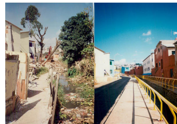
ANTES E DEPOIS DA CANALIZAÇÃO DO CÓRREGO
