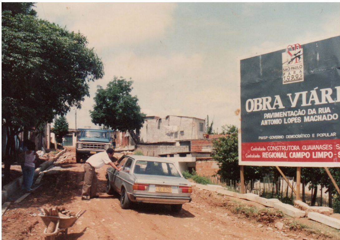
Figura 27: Obras de pavimentação na Rua Antônio Lopes Machado, Rua 17. Foto: Acervo Família Garcia, início da década de 1990.
