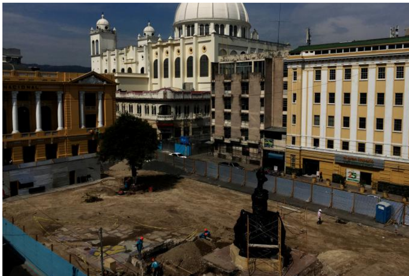
Obras de remodelación en la plaza Morazán del Centro Histórico, en 2017, cuando Bukele fue alcalde de San Salvador. Foto: Víctor Peña.
