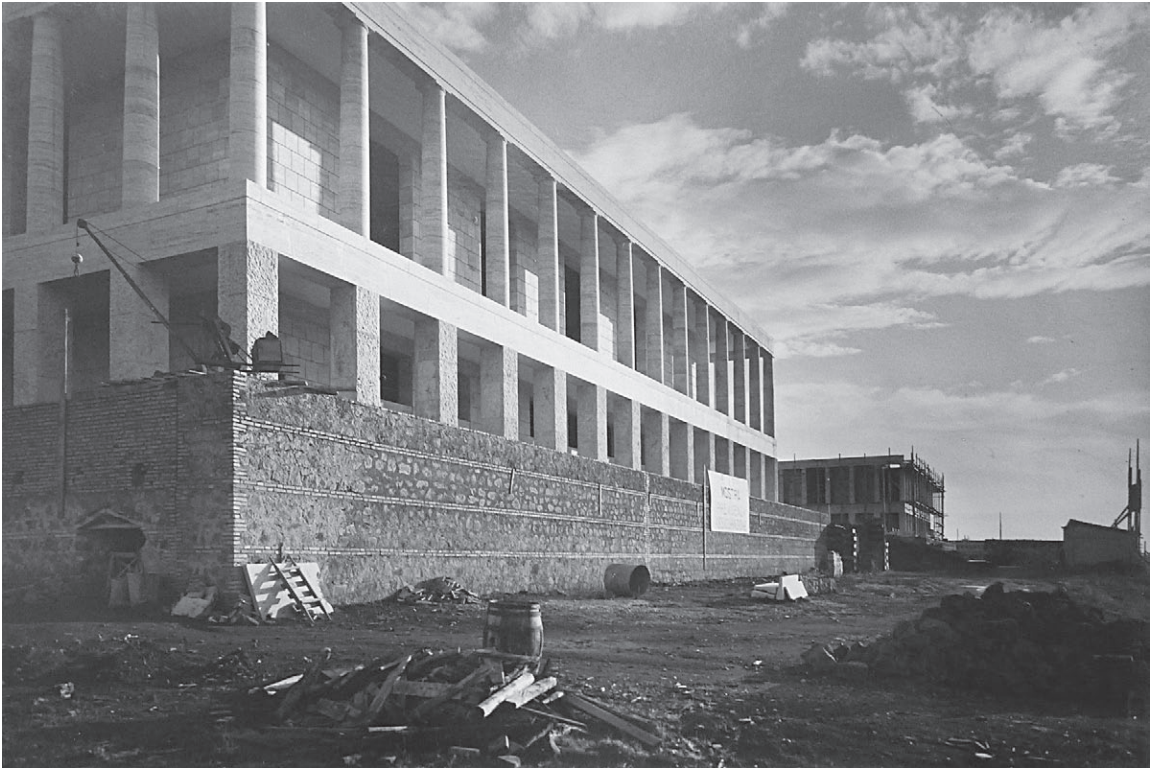
Fig. 9.4 Mario De Renzi and Gino Pollini, Edifici del Corporativismo, dell'Autarchia e dell'Assistenza e Previdenza Sociale, 1943. General view under construction. Courtesy of Archivio Centrale dello Stato, Carte Gaetano Minnucci, Buste 142, Fascicolo 258, Sottofascicolo 2, photo 4880.
