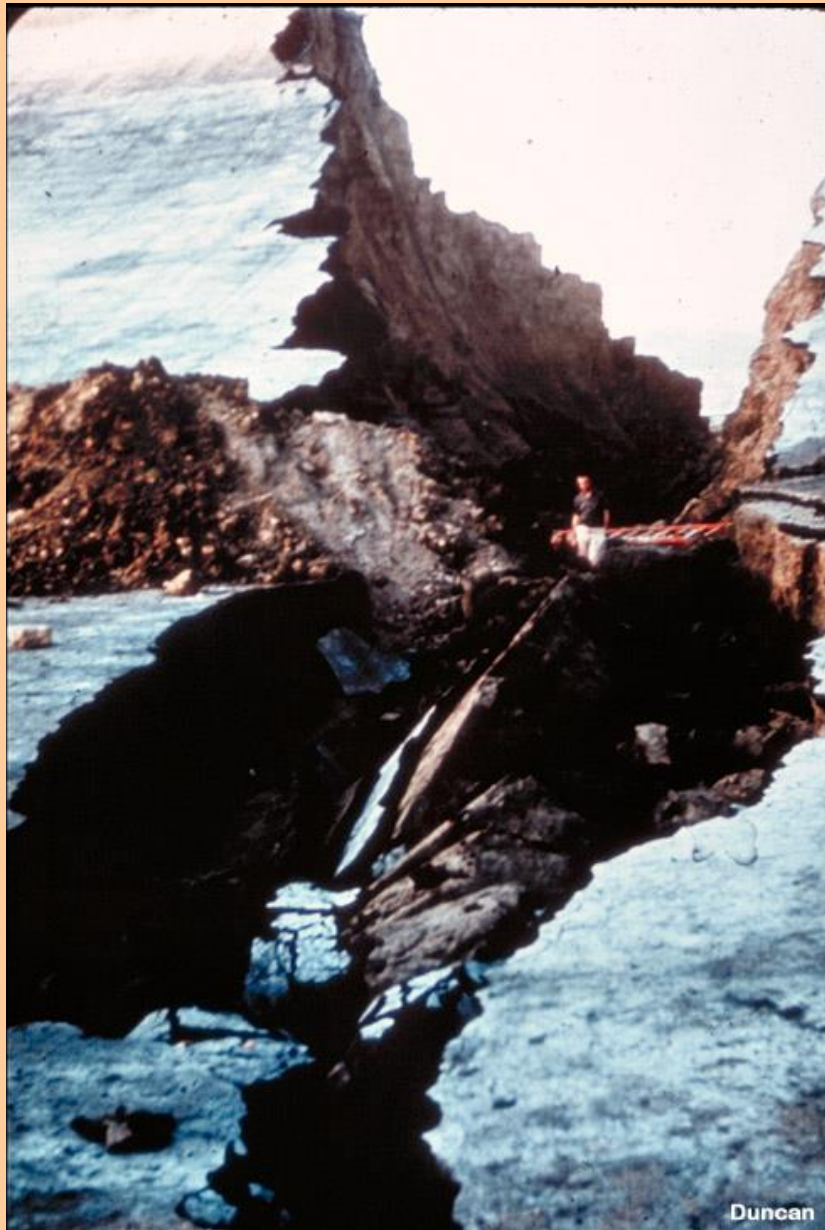
Barragem Baldwin Hills (rompeu em 1963 por “piping”)
