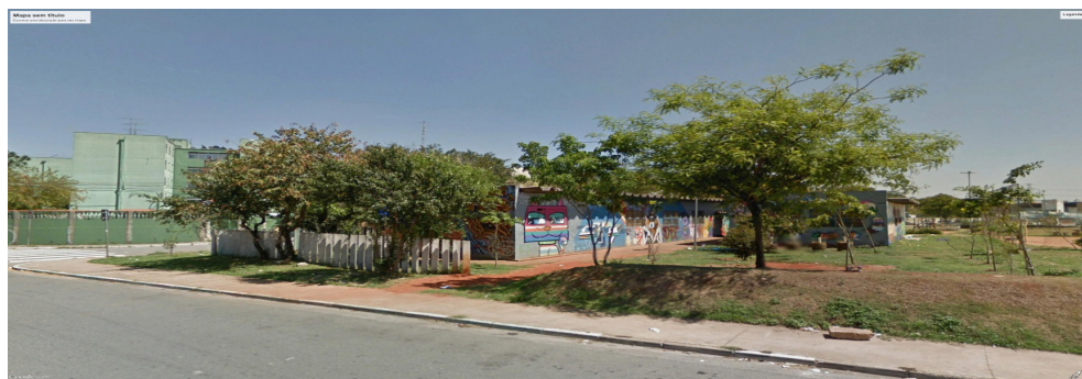
Figura 07: Sede do coletivo. Fonte: Google Street View. Acesso em jun./2017
