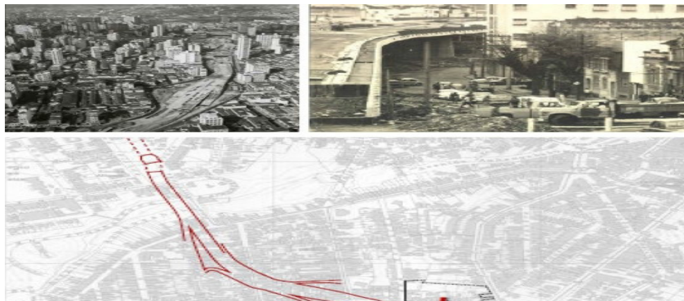
Figuras 7 e 8: Construção do Elevado Costa e Silva, Minhocão, e impacto no Bixiga Fonte: http://www.vitruvius.com.br/revistas/read/minhacidade/15.180/5617 . Acesso em 17/10/2017.
