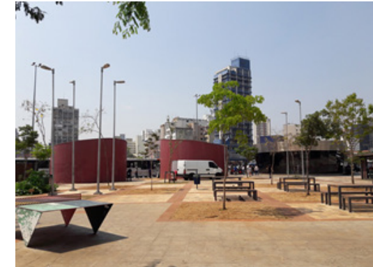
Figura 08: Volumes da estação Faria Lima no Largo da Batata, blocos de ventilação em vermelho, à esquerda e ao centro, e acesso principal em vidro fosco escuro à direita. Foto: Luísa Gonçalves, 2017.
