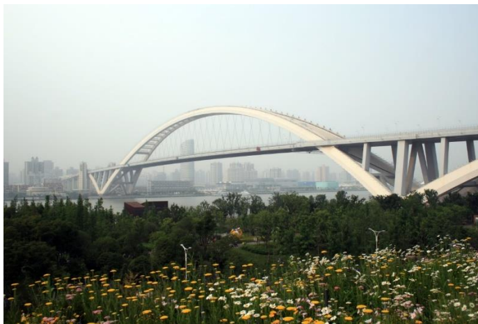
Lupu Bridge, China, 2003 Maior Ponte de Arco – vão550m
