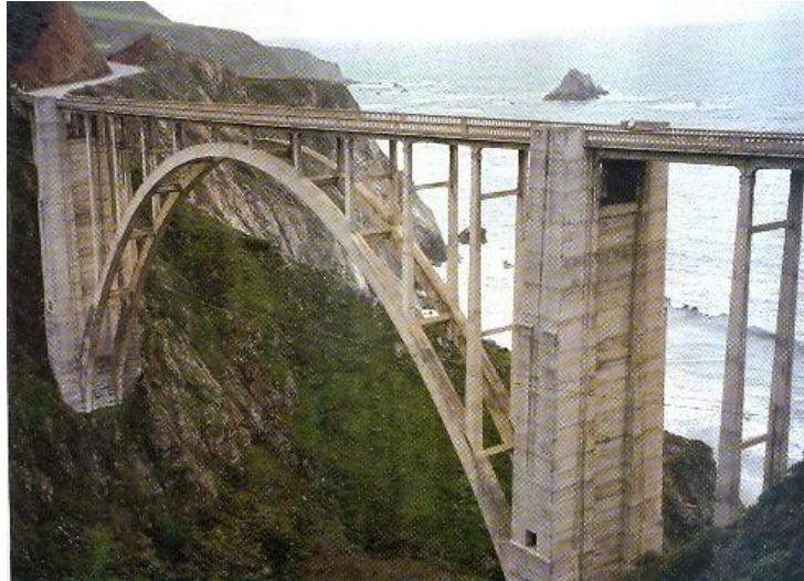
BIXBY CREEK BRIDGE – California – Estados Unidos - 1932
