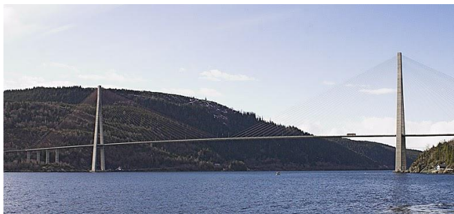
Skarnsund, Noruega, 1991 Estaiada de concreto – vão 530m
