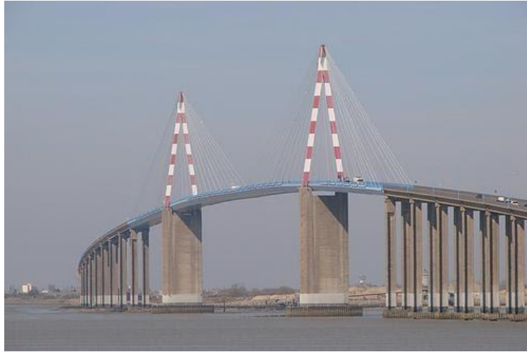
Saint Nazaire, França, 1998 Estaiada aço/concreto – vão 890m
