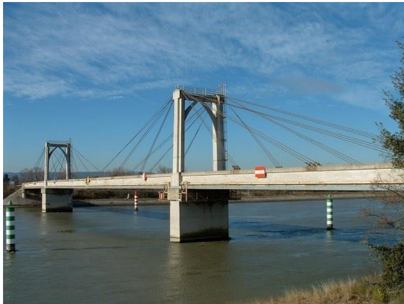
Ponte Donzère, França, 1952 Primeira ponte estaiada moderna – vão 81m
