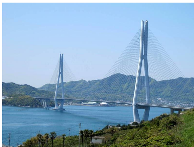
Tatara, Japão, 1999 Estaiada aço/concreto – vão 890m
