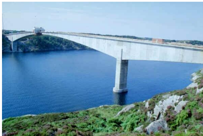
Stolmasundet, Noruega, 1998 Viga de concreto – vão 301m
