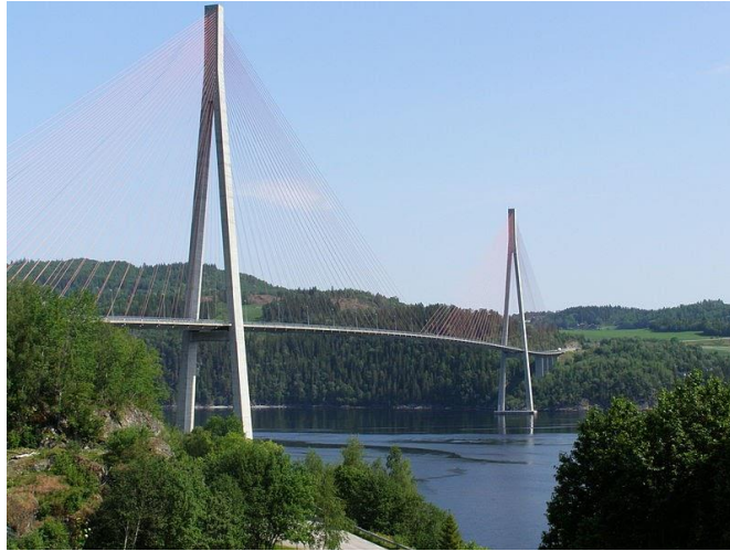
Skarnsund, Noruega, 1991 Estaiada de concreto – vão 530m
