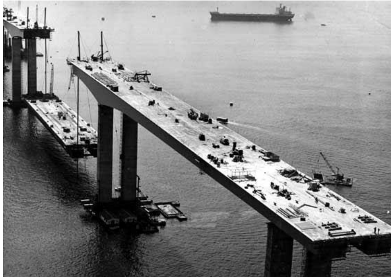
Rio-Niterói, Brasil, 1974 Viga de aço – vão 300m
