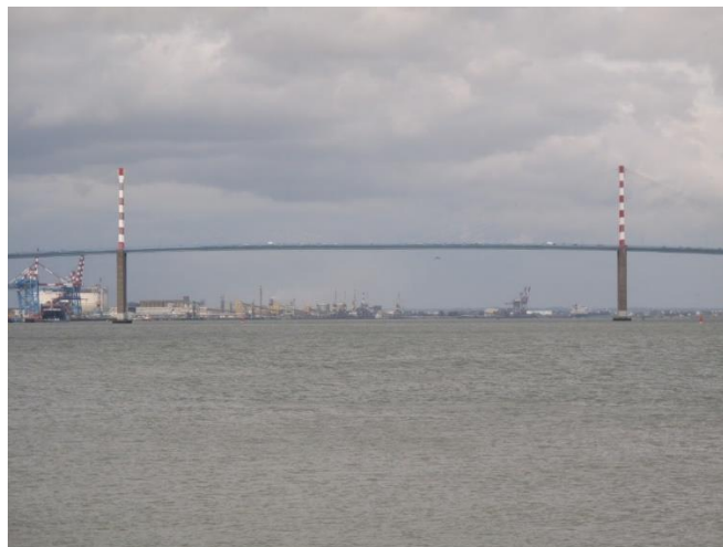
Saint Nazaire, França, 1998 Estaiada aço/concreto – vão 890m
