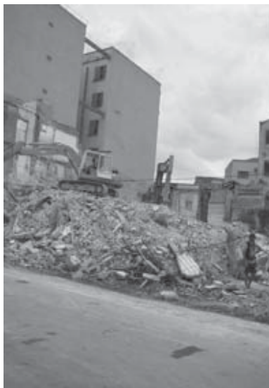
Foto 2: Demolição na Luz (Hélène Rivière D’Arc, 3/11/2007)
