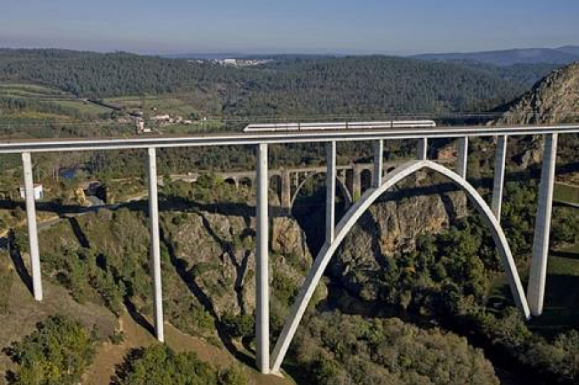
Viaducto del Ulla, 2011. 630 metros de comprimento, altura máxima 117m, vão principal 168m.
