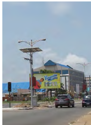
Acra, Gana Iluminação urbana alimentada por energia solar para reduzir a dependência da eletricidade.
