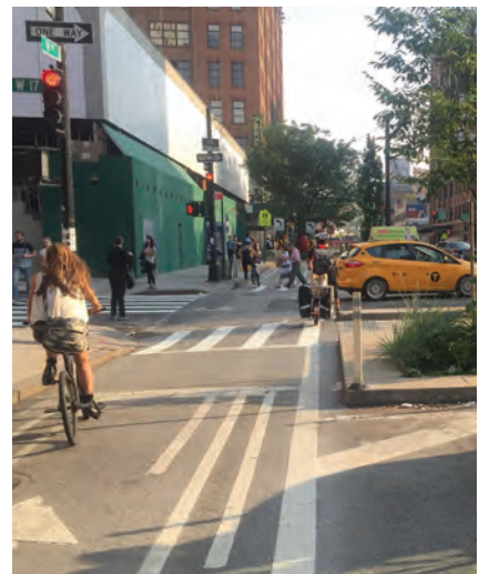
Nova York, EUA. Uma ilha de refúgio de pedestres e elementos de infraestrutura verde alinhados com a faixa de estacionamento reduzem as distâncias de travessia e aumentam a segurança do cruzamento.
