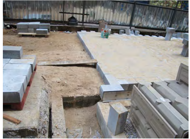
São Paulo, Brasil Canais de drenagem em obras para um projeto de repavimentação de rua.
