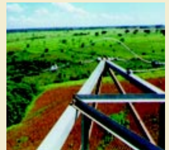
Cabo Óptico Aéreo - OPGW em Torre de Linha de Transmissão
