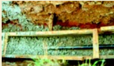
Envolvimento (Concreto) Diretamente sobre o Cabo Óptico DPE-G
