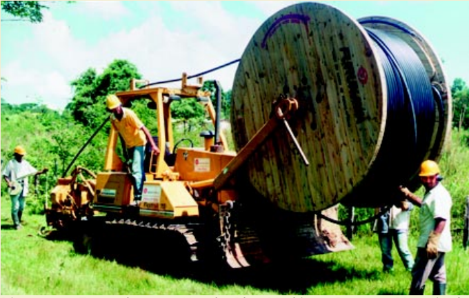
Diretamente Enterrado com o Uso de "Plow Machine" - Processo Mecanizado
