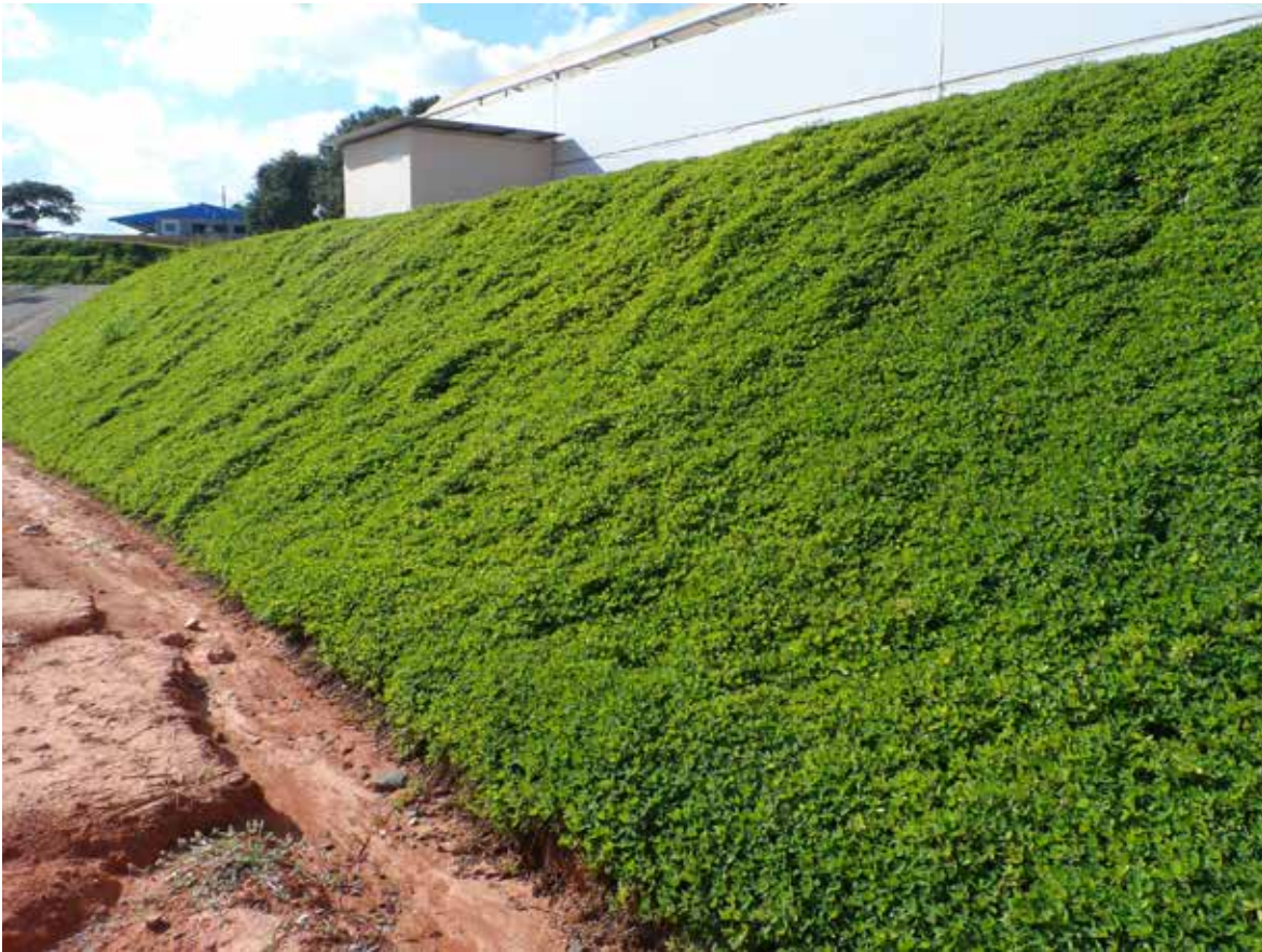
FIGURA 3 - Exemplo da utilização da grama-amendoim na contenção de encosta. Foto: Julcía Camillo
