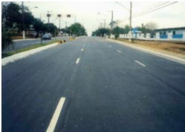
(a) areia asfalto a frio em via urbana
