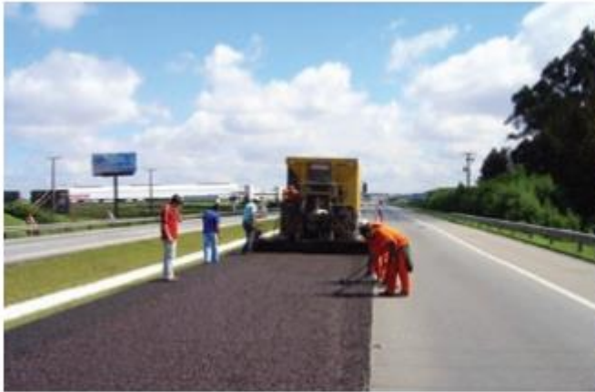
Figura X.4 – Aplicação de microrrevestimento asfáltico em rodovia de alto tráfego
