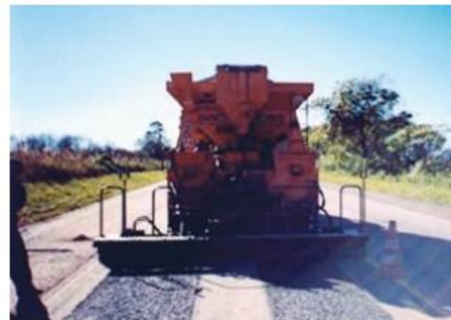
Figura X.3 – Aplicação de MRAF para o preenchimento de trilhas de roda
