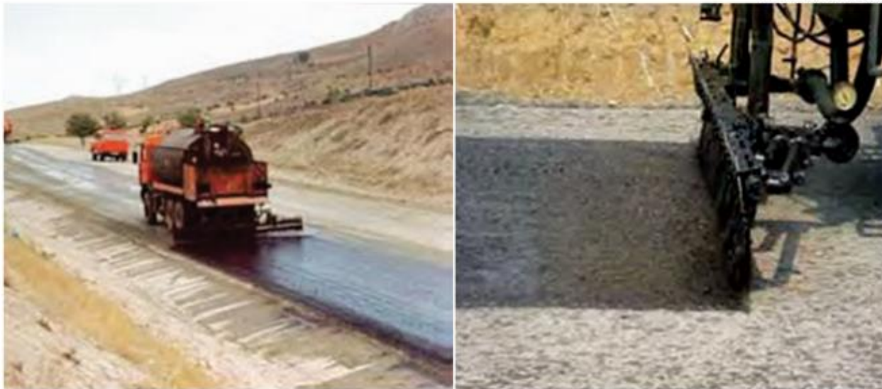
(a) aplicação da EAI sobre base granular
