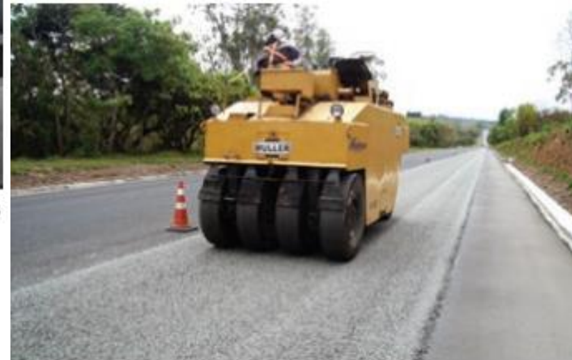
Figura VII.8 – Aplicação simultânea de emulsão asfáltica elastomérica e agregados através do equipamento multidistribuidor
