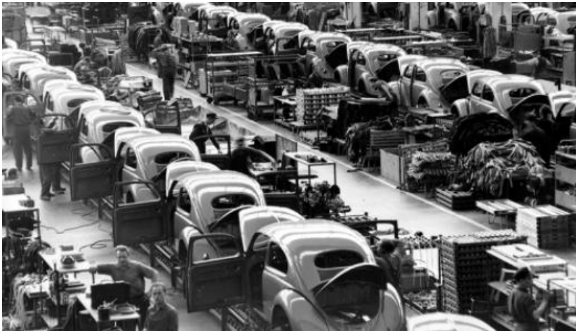
Linha de montagem final do Volkswagen Beetle
