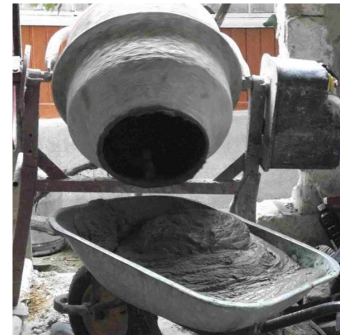
Preparação de uma batelada de cimento (pedra, cimento, água, areia)
