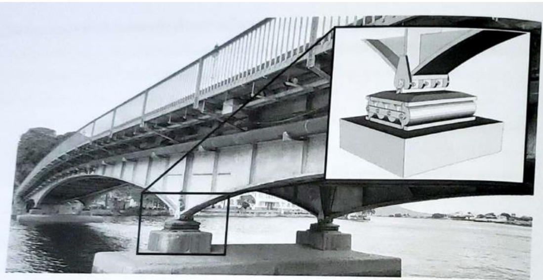
Fig. 2.18 Aparelho de apoio sobre rolos metálicos na ponte de acesso à Ilha das Cobras (RJ)
