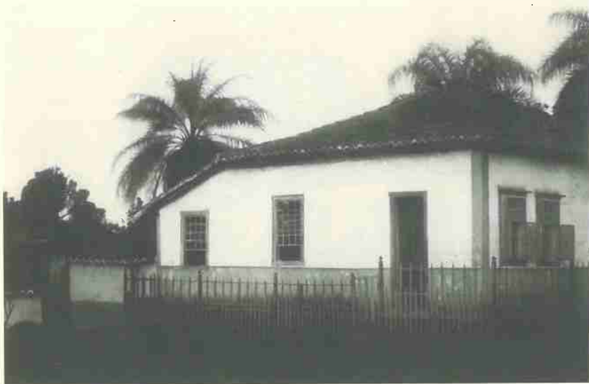
Fig. 3.4 Fachada lateral da casa de Peter Lund em Lagoa Santa, MG. Original de Eugenio Warming, depositado no Museu Botânico de Copenhague.
