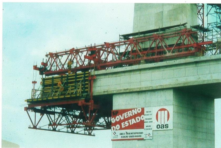
Treliça de escoramento dos segmentos do tabuleiro da ponte (fotografia de Anderson Glauco Benite)
