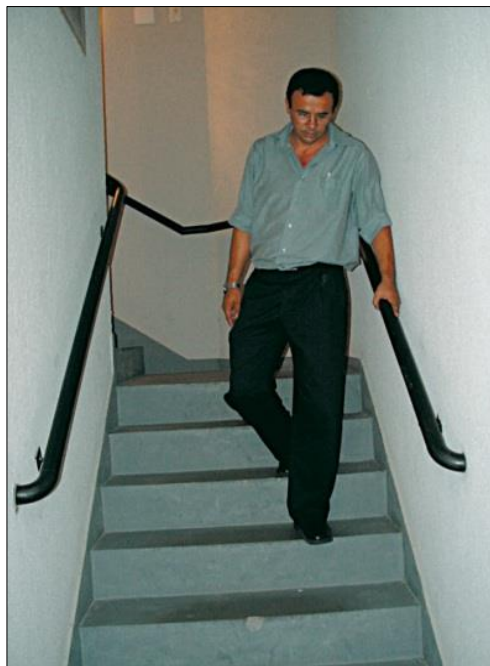
Figura 36: Escada com largura apropriada para saída das pessoas.
