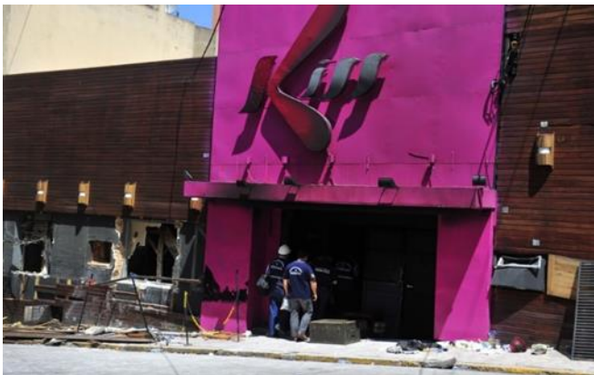
Figura 7: Incêndio em local de reunião de público (casa noturna)
