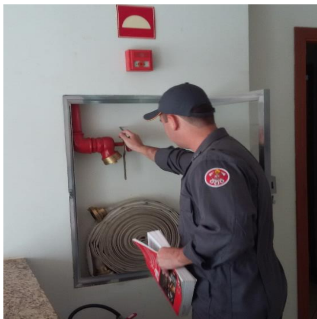
Figura 1: Vistoria em edificação para verificação das medidas de segurança contra incêndio e pânico.
