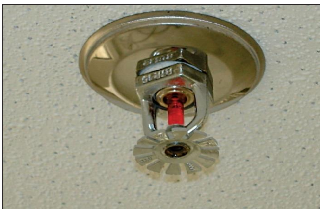
Figura 58: Chuveiro automático.
