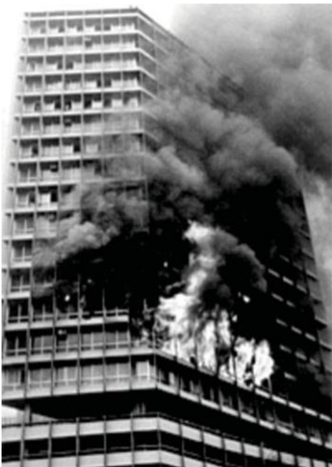
Figura 4: Incêndio no Edifício Joelma
