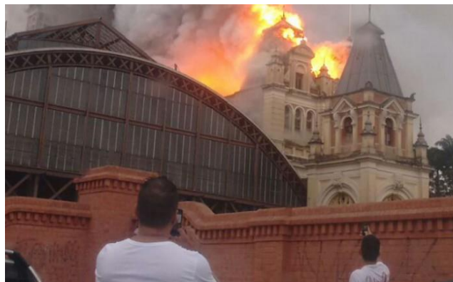
Figura 10: Incêndio no Museu da Língua Portuguesa
