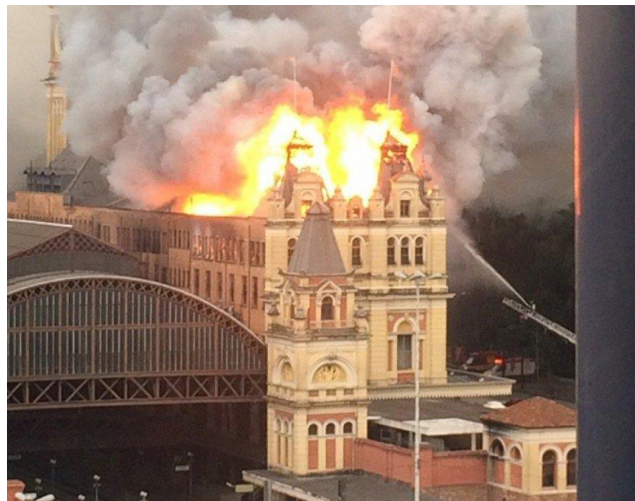
Figura 11: Incêndio no Museu da Língua Portuguesa
