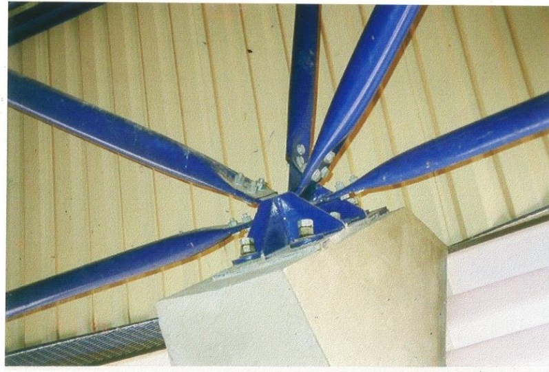
Detalhe de um dos apoios da cobertura (fotografia de Nayra Tais Savordelli)
