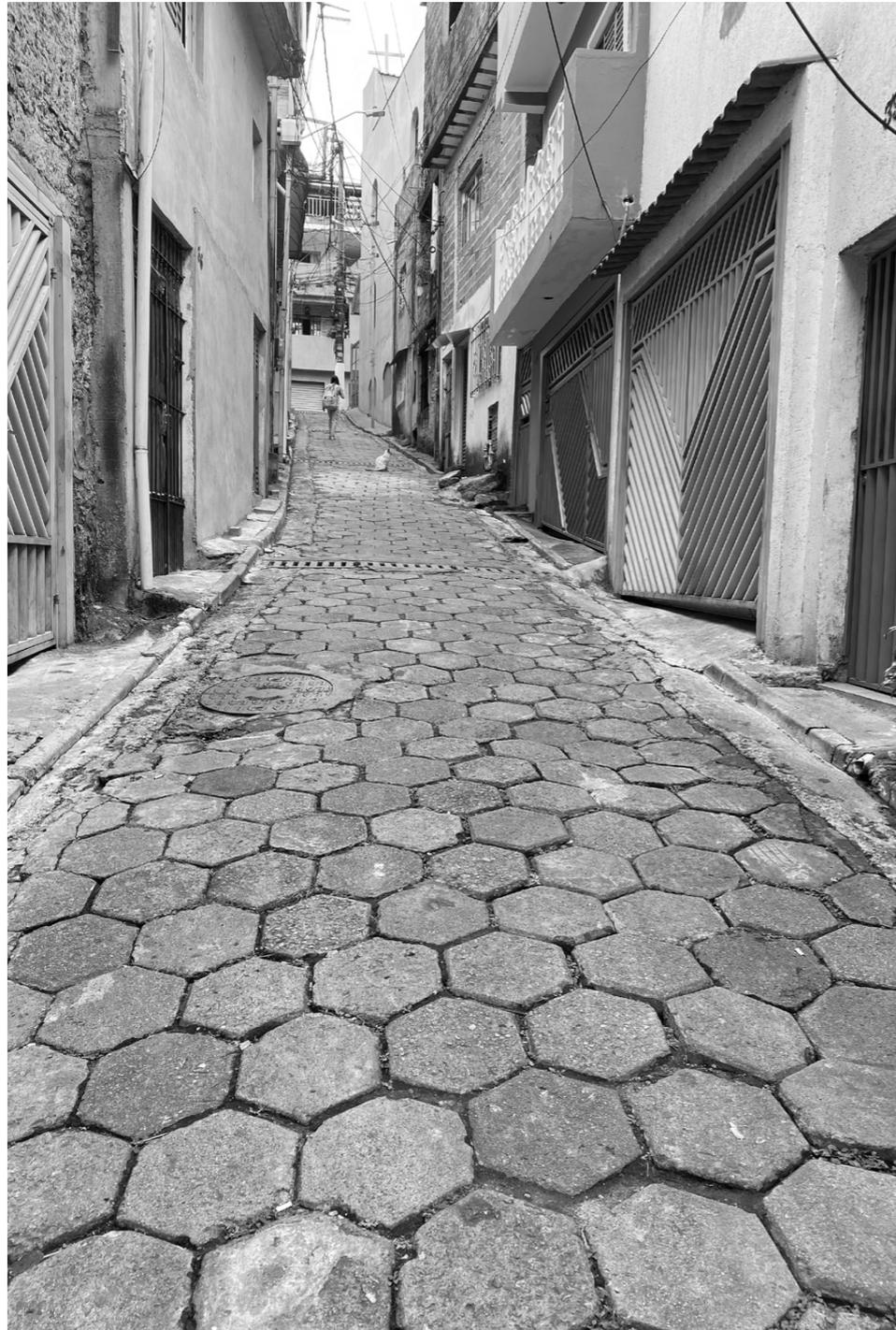
Nota-se a presença de paralelepípedos hexagonais usados na pavimentação de algumas ruas próximas à fonte (talvez) indicando uma necessidade maior de permeabilização do solo nessas áreas de cursos d'água.
